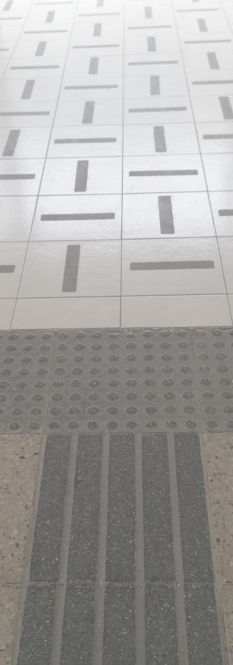
Fig. 40: Acceso a Edificio A. Huellas podotáctiles de avance y detención, Colegio Santa Lucía. Archivo personal
