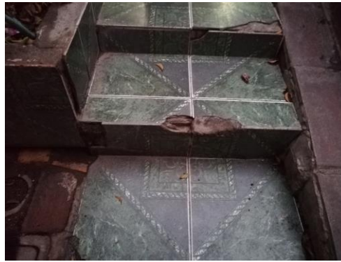
Fig. 72: Detalle de peldaños entrada principal. Archivo personal
