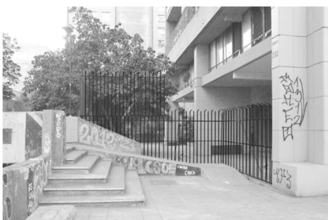
Fig. 13 Rejas de doble altura reforzadas despues del estallido social. Torre 2. Elaboracion propia
