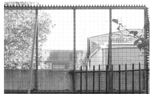
Fig. 24 Reja informal instalada por conserjes, Torre 2 de la Remodelación San Borja. 2021. Fotografía de Javiera O'Ryan
