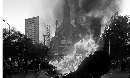
Fig. 21 Incendio Iglesia San Francisco de Broja 2020. Etraida de Emol
