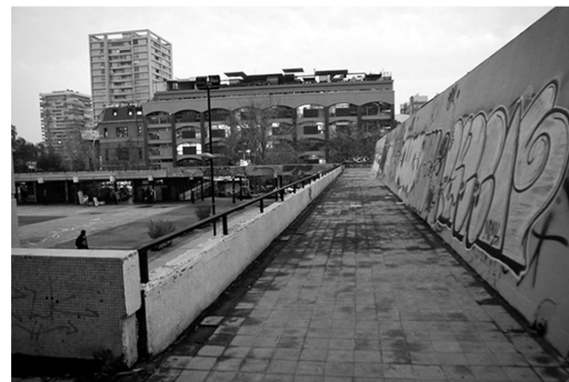
Fig. 22 Estado actual de pasarelas. Foto extraida de bases del concurso pasarelas San Borja
