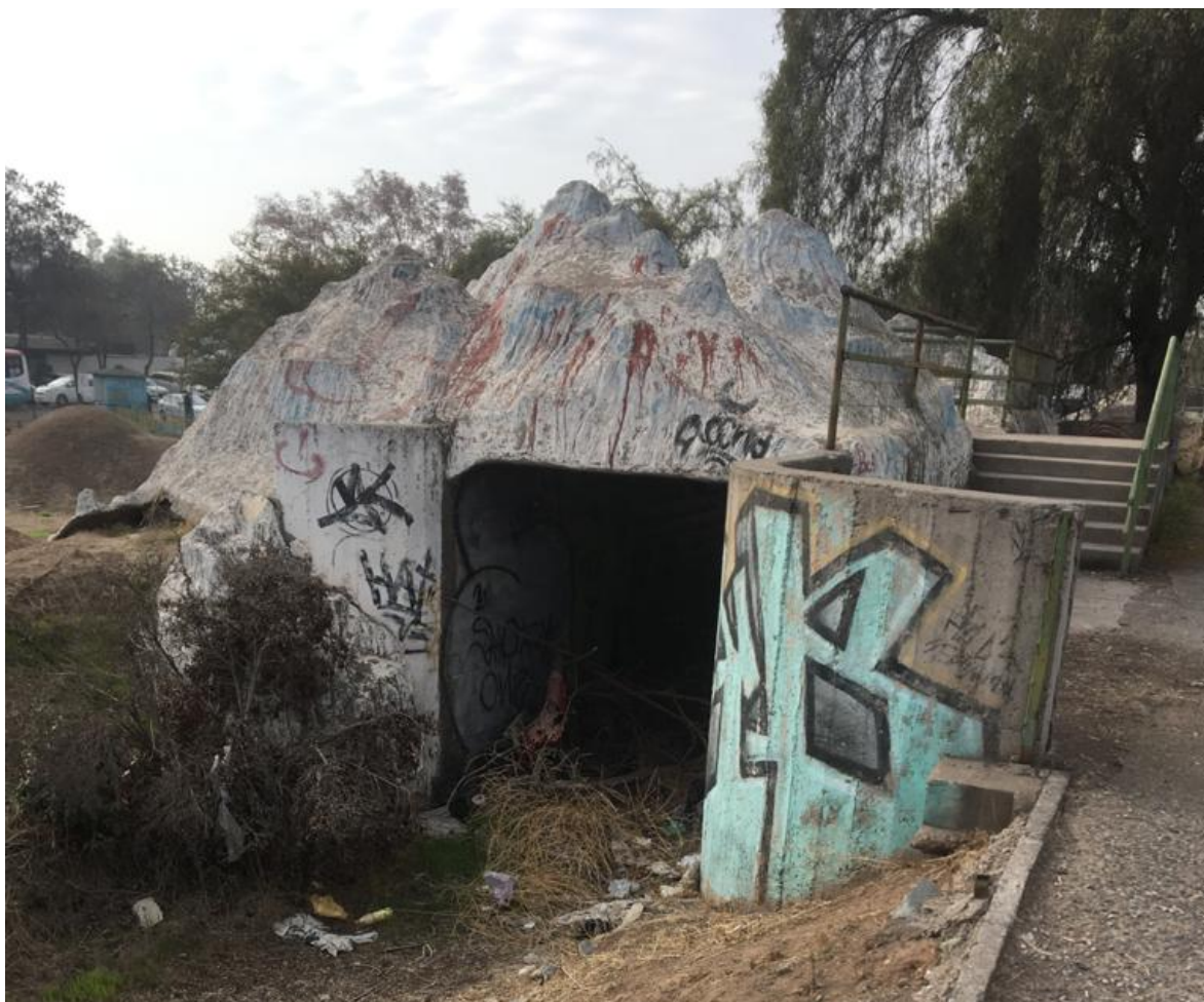
Mundo Mágico en el abandono (2021). Vista: interior de lo que fue el Volcán Villarrica. Fotografía tomada por Emiliana Cereceda en la primera visita al lugar, antes de que el espacio interior del volcán fuese clausurado. Vista desde el extremo norponiente del parque hacia el oriente.
