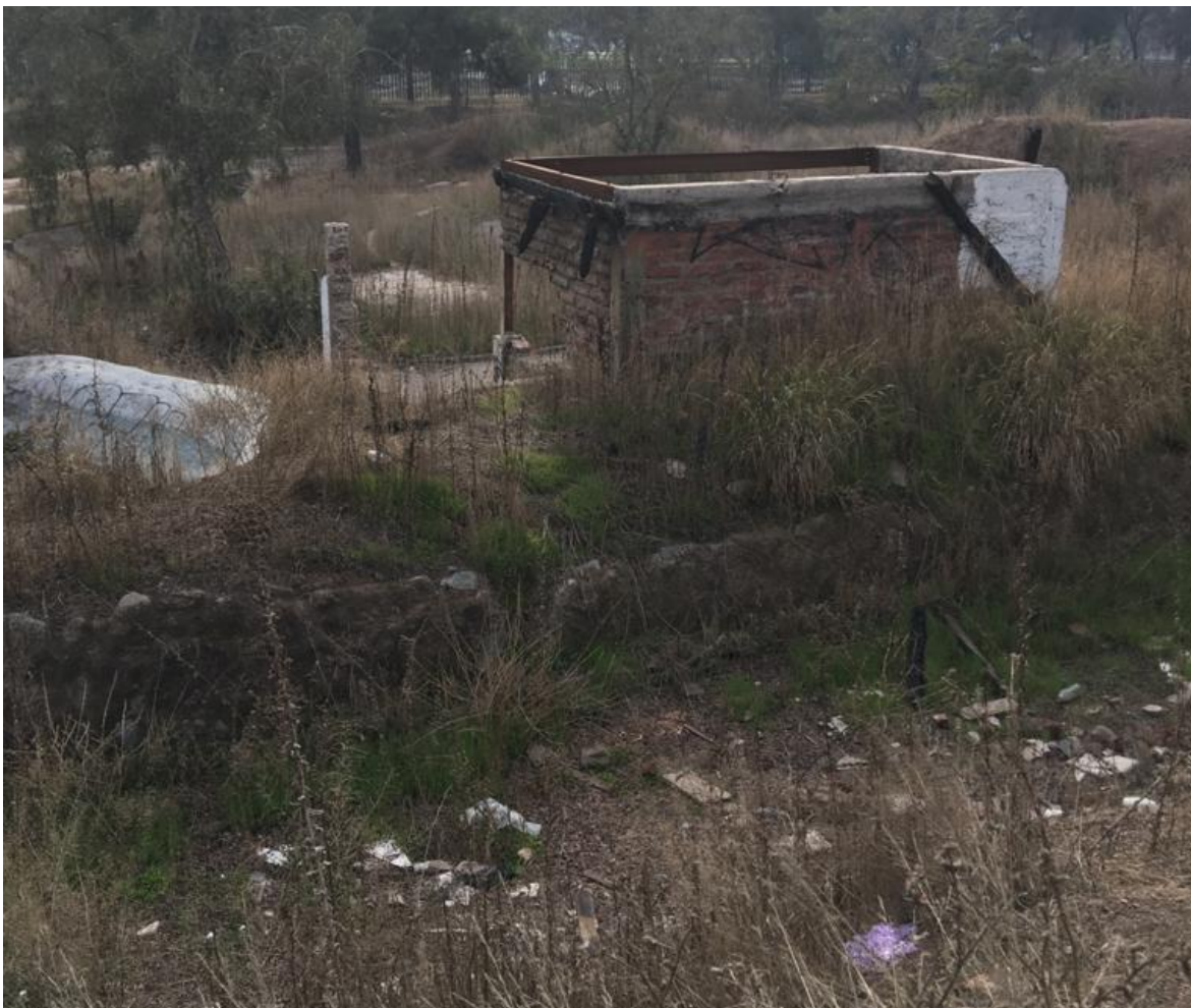
Mundo Mágico en el abandono (2021). Vista: estructura de ladrillos abandonada y quemada, con basura y vegetación alrededor. Fotografía tomada por Emiliana Cereceda, desde la franja norte del parque, mirando hacia el sur.
