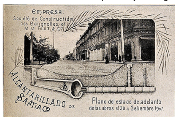
Figura 12. Esquema de cómo funcionaba el sistema de desagües y su conexión con el alcantarillado principal, en publicación de la revista "Sucesos" en 1907. Fuente: Extraído de https://urbatorium.blogspot.com/2016/08/los-viejos-desagües-pluviales-de-las.html . Consulta en línea 02 de Junio de 2022
