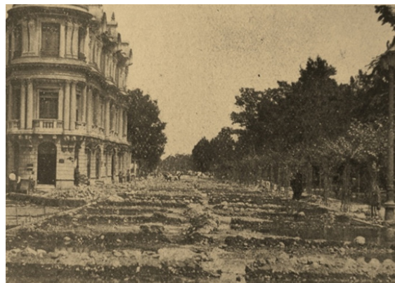
Figura 13. Pavimento de calles Avenida Forestal, Esmeralda y Miraflores. Fuente Zig-Zag 02 de Febrero de 1929 n°1250
