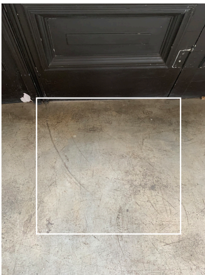
Figura 43. Fotografía tomada en el primer piso, en la ventana que da al patio descubierto. Fuente: Colección de la autora, 2022.
