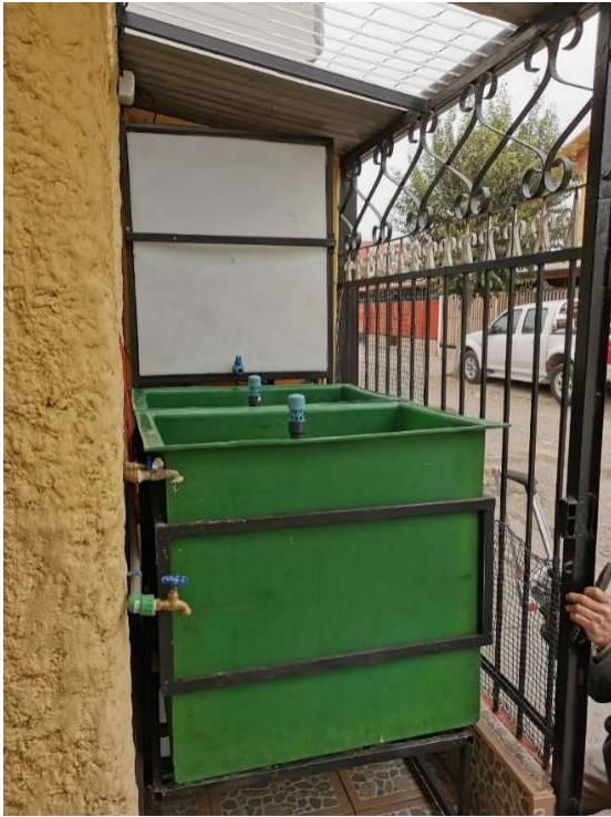
Figura 11 Instalación del prototipo de humedal artificial. Fuente: Gidi, (2022).
