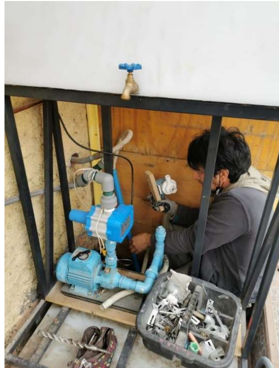
Figura 12 Instalación del prototipo de humedal artificial. Fuente: Gidi, (2022).
