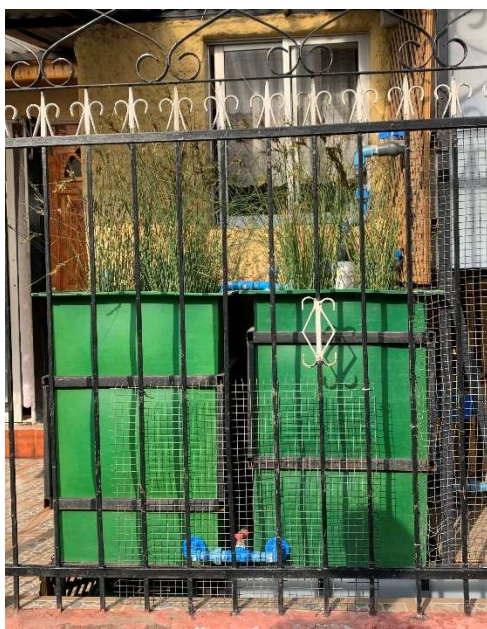
Figura 14 Humedal Artificial Modular noviembre 2022. Fuente: Elaboración propia.
