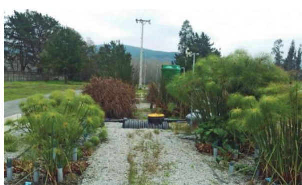
Figura 7 Proyecto Humedales Artificiales en Hualqui. Fuente: Vidal (2016)
