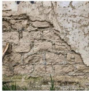
Figura 6: Muro de adobe
