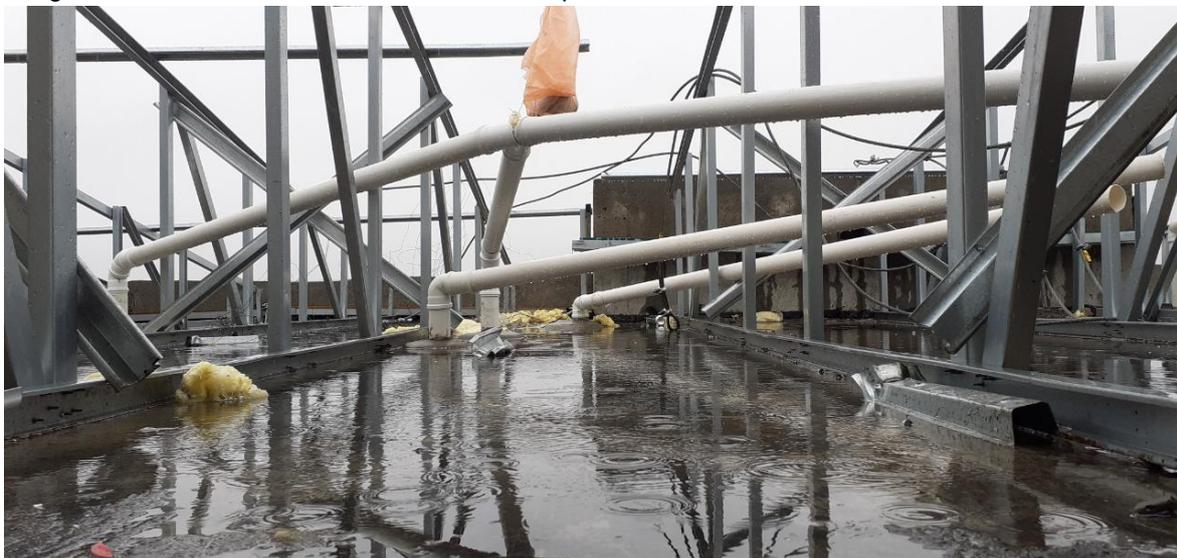
Como se observa en la imagen 24, se evidencia la estructura de techumbre completamente a la intemperie, expuesta al exterior y a las condiciones climáticas inestables de Punta Arenas, la cual se inundó por efecto de la lluvia posterior al desprendimiento de la plancha de cubierta, lo cual generó un empozamiento de las aguas lluvias y las consecuentes filtraciones de goteras en las viviendas.
