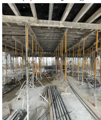
(d) Moldajes de Losas
