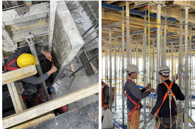
(a) Plomo Muro
