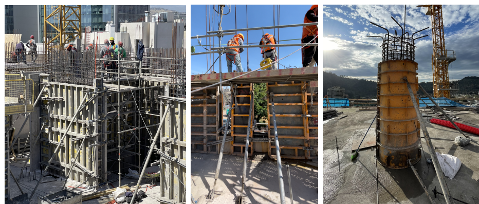
(a) Moldaje Modular (b) Moldaje Ligero (c) Moldaje Circular
