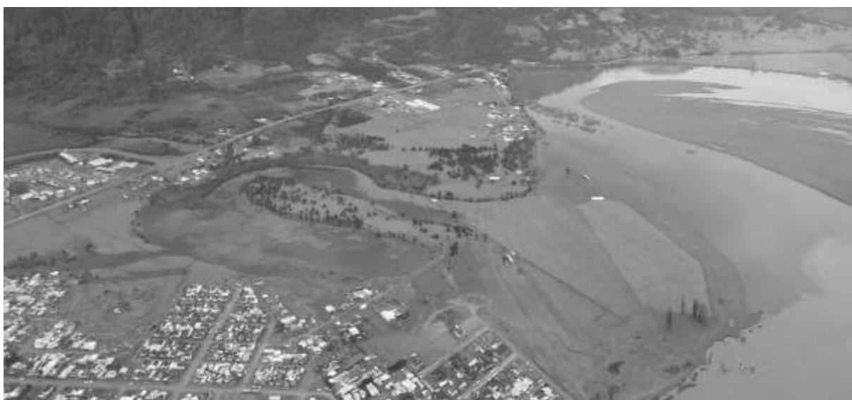
Figura 5. Inundación de los alrededores de la ciudad de Puerto Aysén, tras una semana de lluvias constantes Fuente: a partir de instaram.
