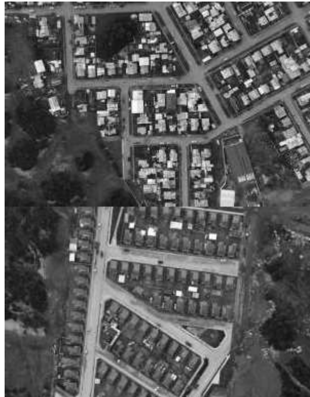
Figura 6. Conjunto de viviendas sociales y su desvinculación con el entorno natural inmediato, Puerto Aysén. Fuente: Elaboración Propia
