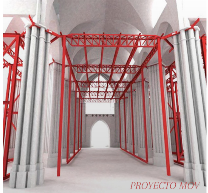
Estructura de refuerzo en proyecto de restauración de Basílica del Salvador. Fundación Basílica del Salvador
