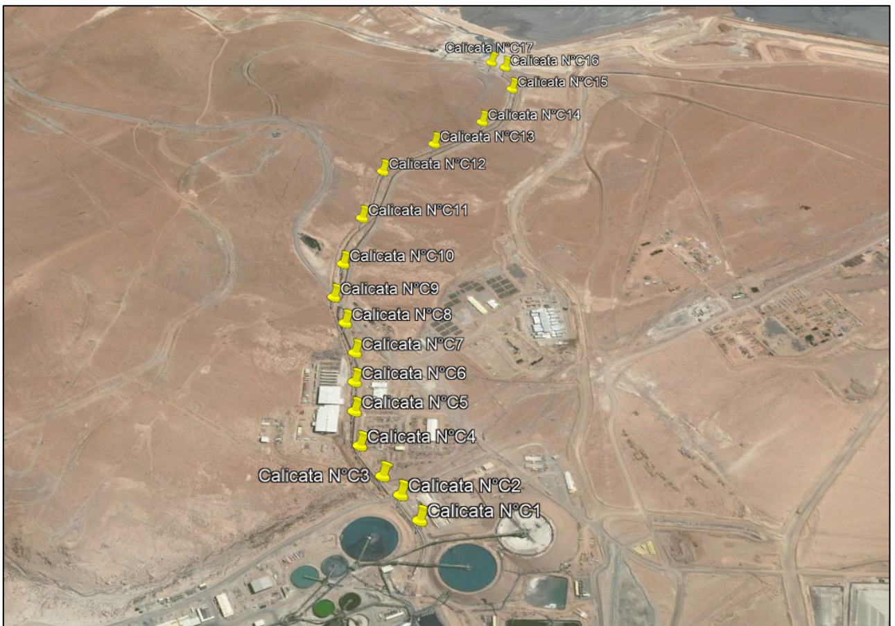
Figura 15: Identificación de Calicatas
