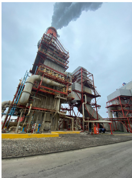
Figura 4.3: Unidad de generación a carbón de la central Guacolda.
