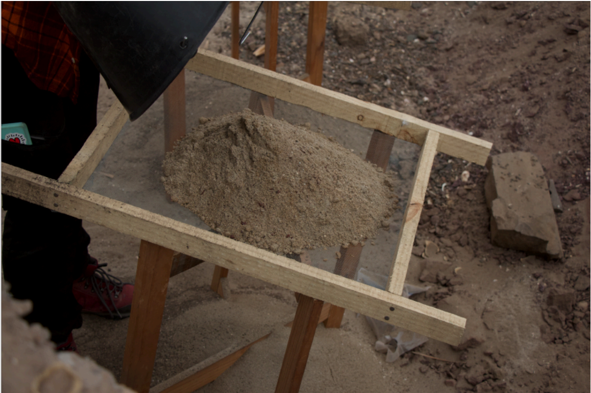
Figura 31. Trabajos de arneo de tierra, fotografía Carolina Quezada, 19 mayo 2023.
