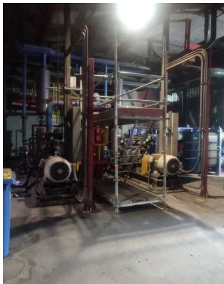
(a) Instalación andamios
