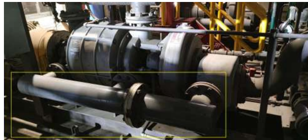
(b) Conexión entre etapas bomba B
