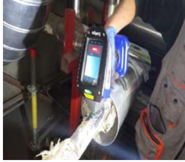
Figura 5.12: Prueba identificación de material
