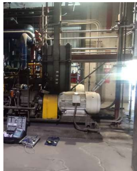
(b) Instalación andamios vista lateral
