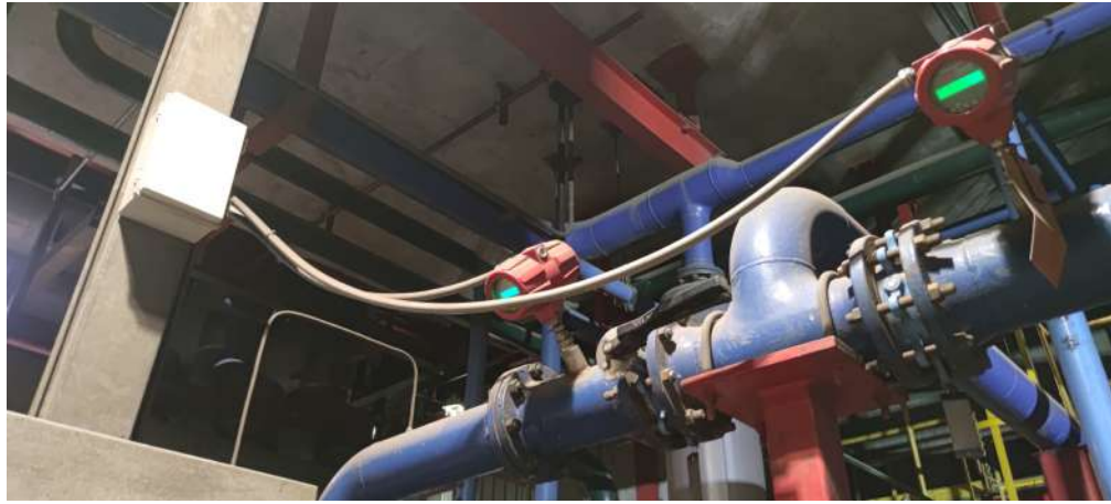
Figura 5.16: Flujómetros en terreno
