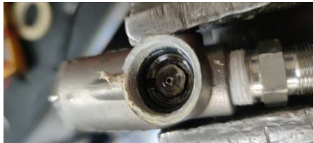
Figura 5.25: Válvula solenoide destapada
