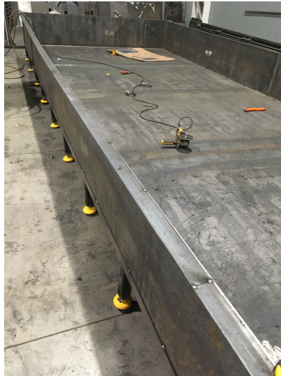
Figura 6.3: Armado de piscina con las paredes laterales
