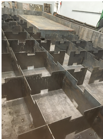
Figura 6.6: Armado de piscina con campanas y enrejado interior.
