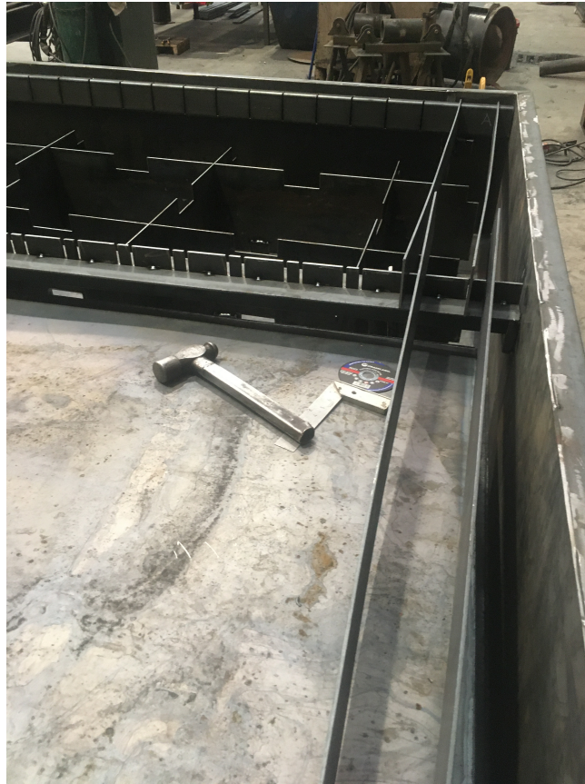
Figura 6.7: Apoyos y soportes barras de corte.
