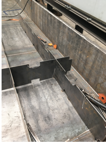
Figura 6.5: Armado del enrejado interior.
