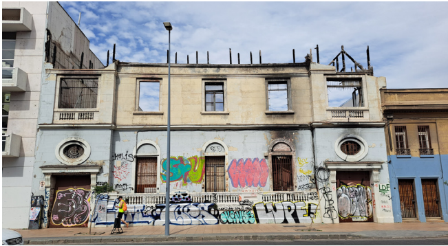
Figura 58. Fachada. Fuente: Elaboración propia.
