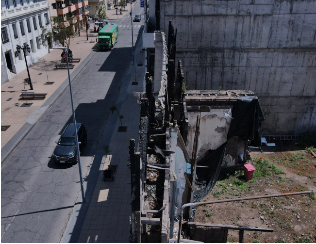
Figura 64. Fachada. Fuente: Elaboración propia.
