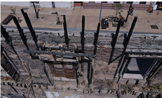
Figura 65. Fachada. Fuente: Elaboración propia.
