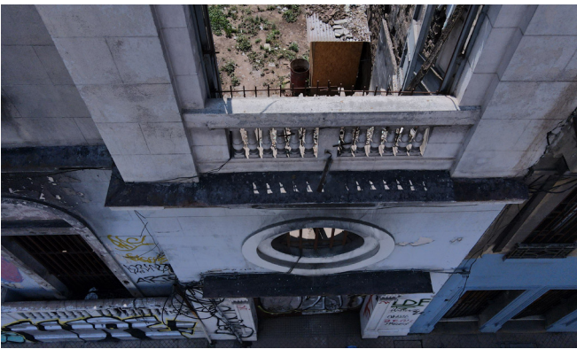
Figura 59. Fachada. Fuente: Elaboración propia.
