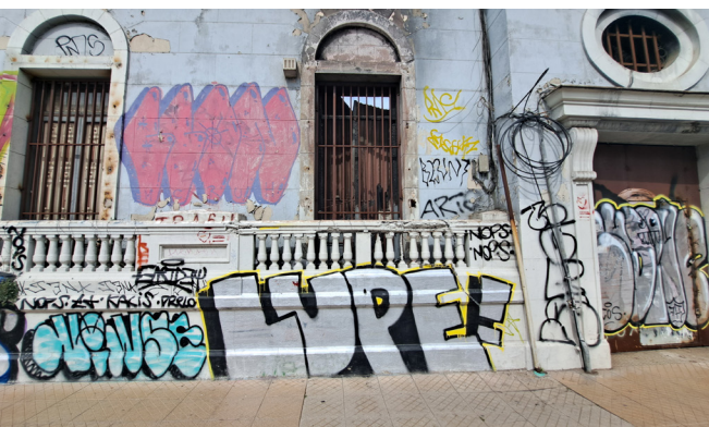
Figura 60. Fachada. Fuente: Elaboración propia.
