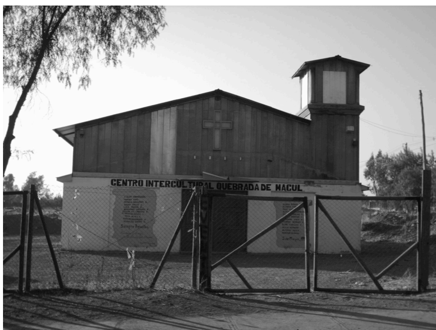
Fig. 26. Photographie d'un centre culturel construit suite aux coulées de boue de 1993 dans le quartier de Santa Teresa, 2008. Source : photographie de l'auteure.
