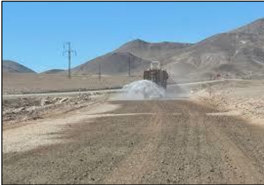
Figura 24: Riego con bischofita
