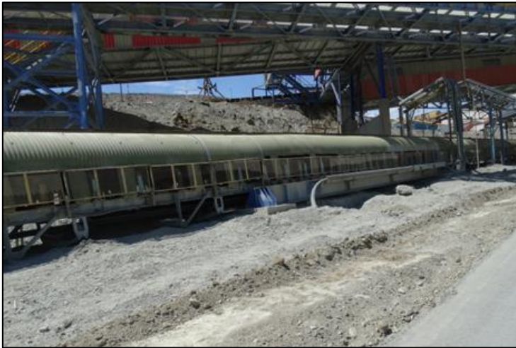
Figura 37: Interferencia - Línea eléctrica 13,8 kV
