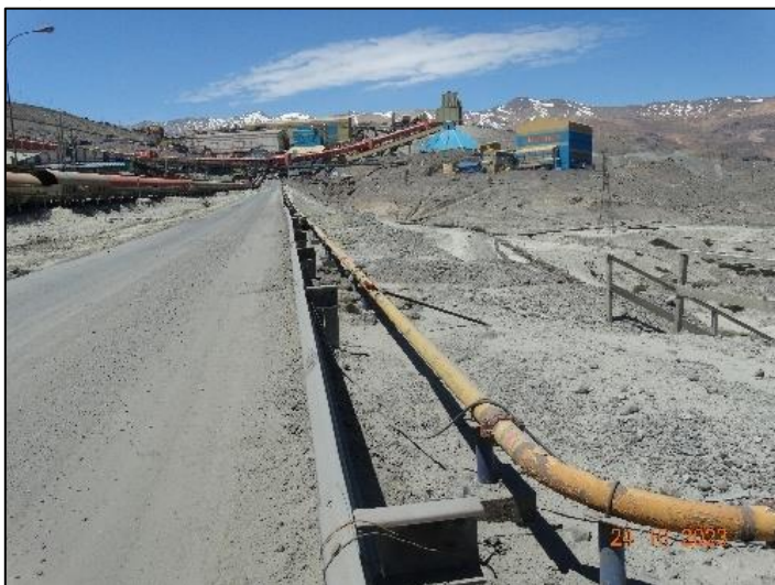
Figura 34: Cañería lechada de cal existente
