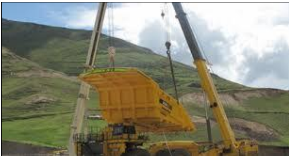
Figura 43: Montaje de tolva camión minero - maniobra simétrica
