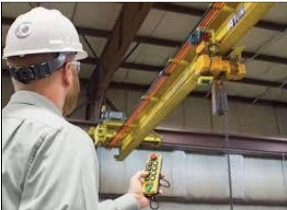
Figura 46: Maniobra con puente grúa
