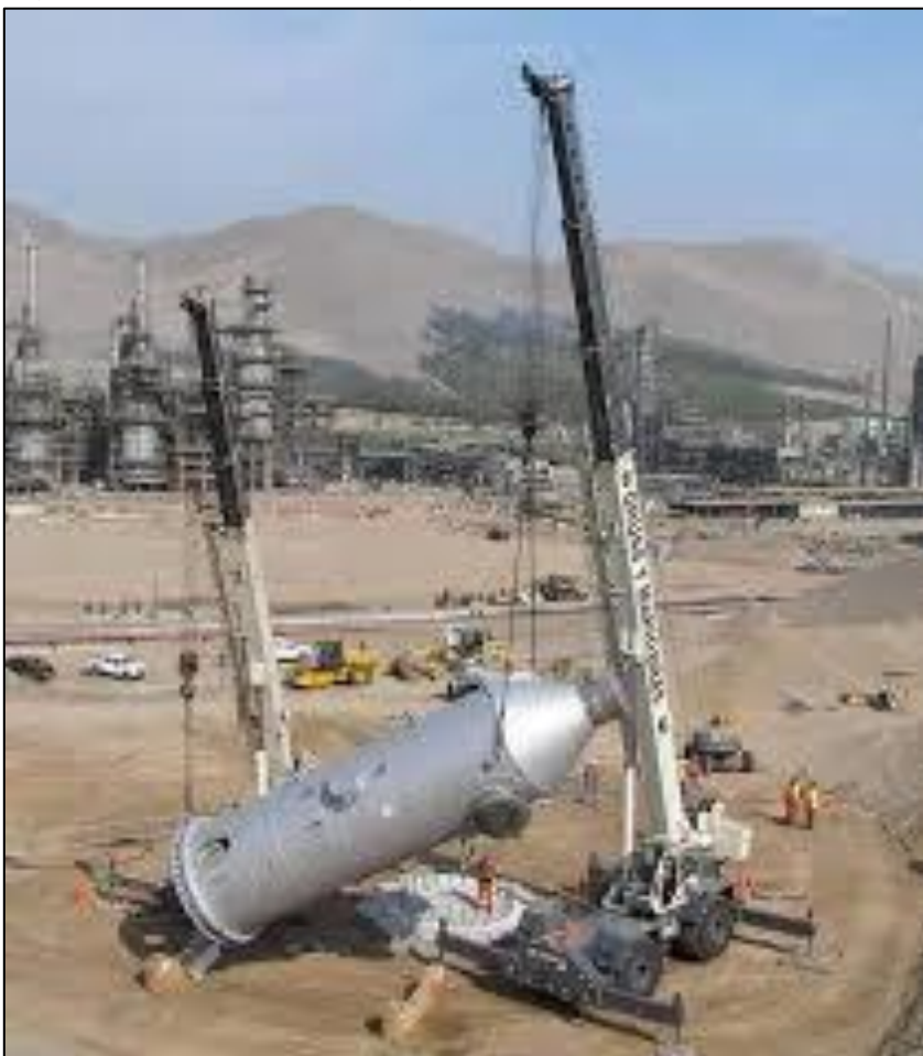
Figura 45: Montaje a dos grúas
