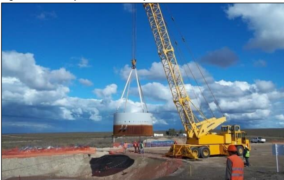
Figura 47: Montaje de alto tonelaje – base turbina
