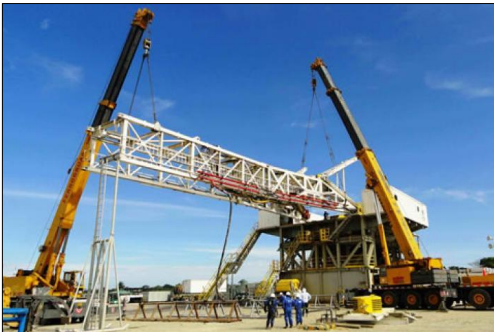
Figura 42: Montaje de estructura - maniobra simétrica
