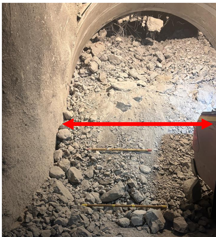
Figura 18: Material post tronadura de una zanja.
