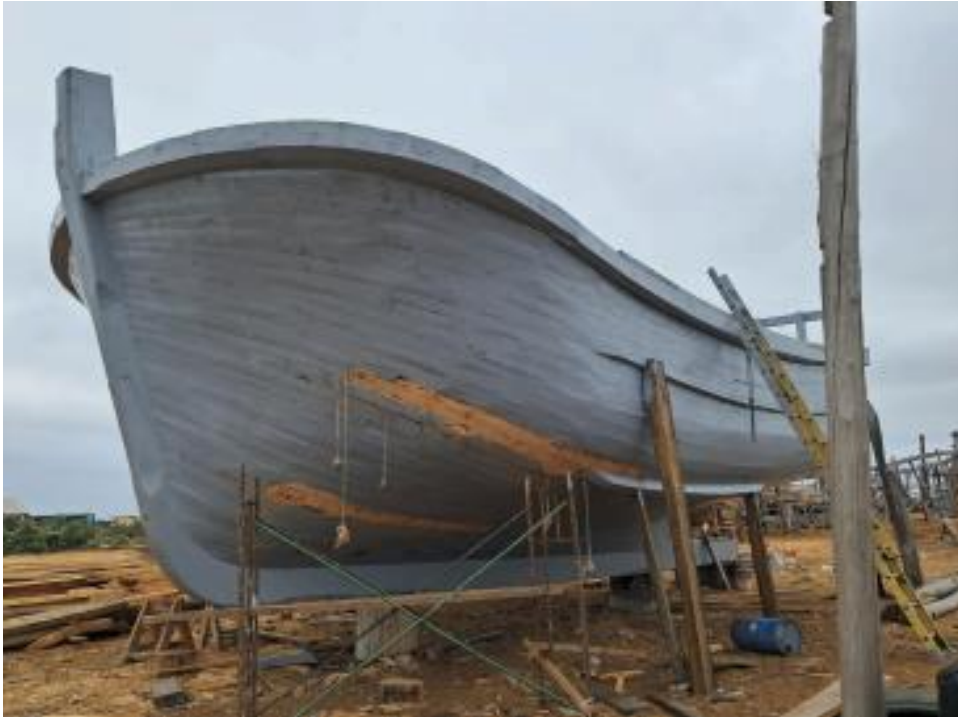
Lancha en construcción
