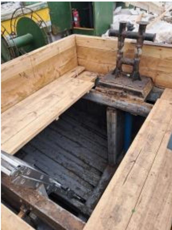
Entrada a bodega, por norma se debe tapar para proteger el producto. (Abierta por mantención)
