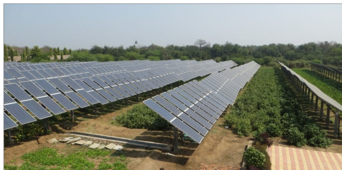
Figura 2.1: Sistema agrivoltaico de 1 [MWp] en el estado de Guyarat, India. Fuente: NSEFI.
