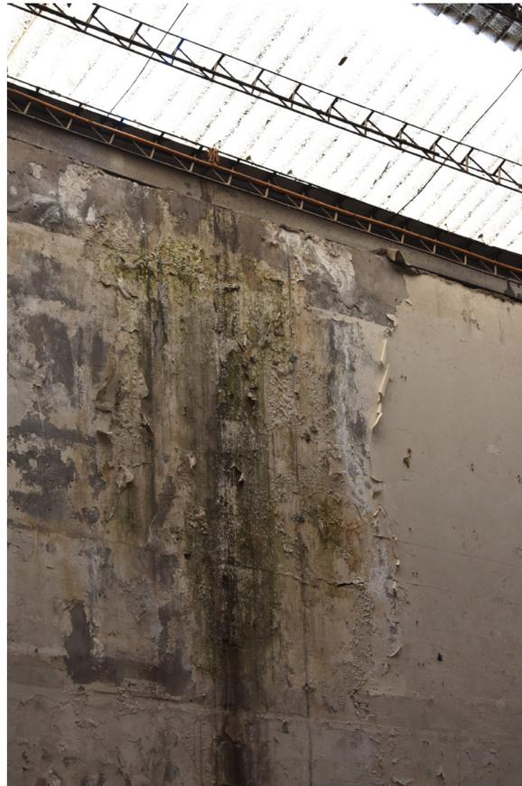
desprendimiento de pintura, debido a posibles desperfectos que debe tener el tragaluz. En cuanto a los marcos de acero se ve corrosión.
