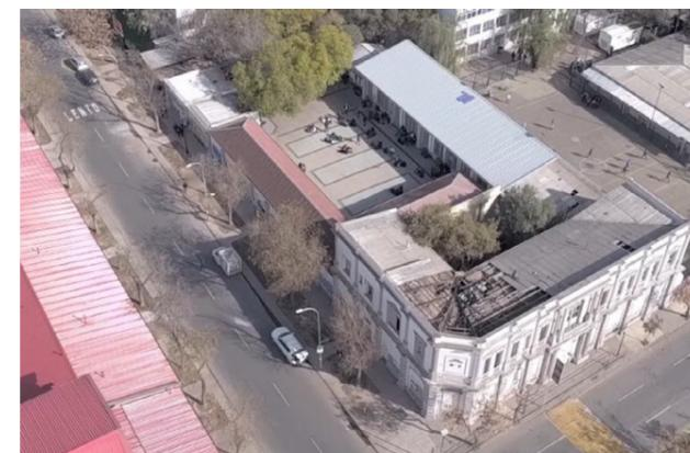
Fig. 44. Vista area del estado de la cubierta del inmueble post incendio. [Fotografía]. Recuperado de documento PRB Portales-Matucana
