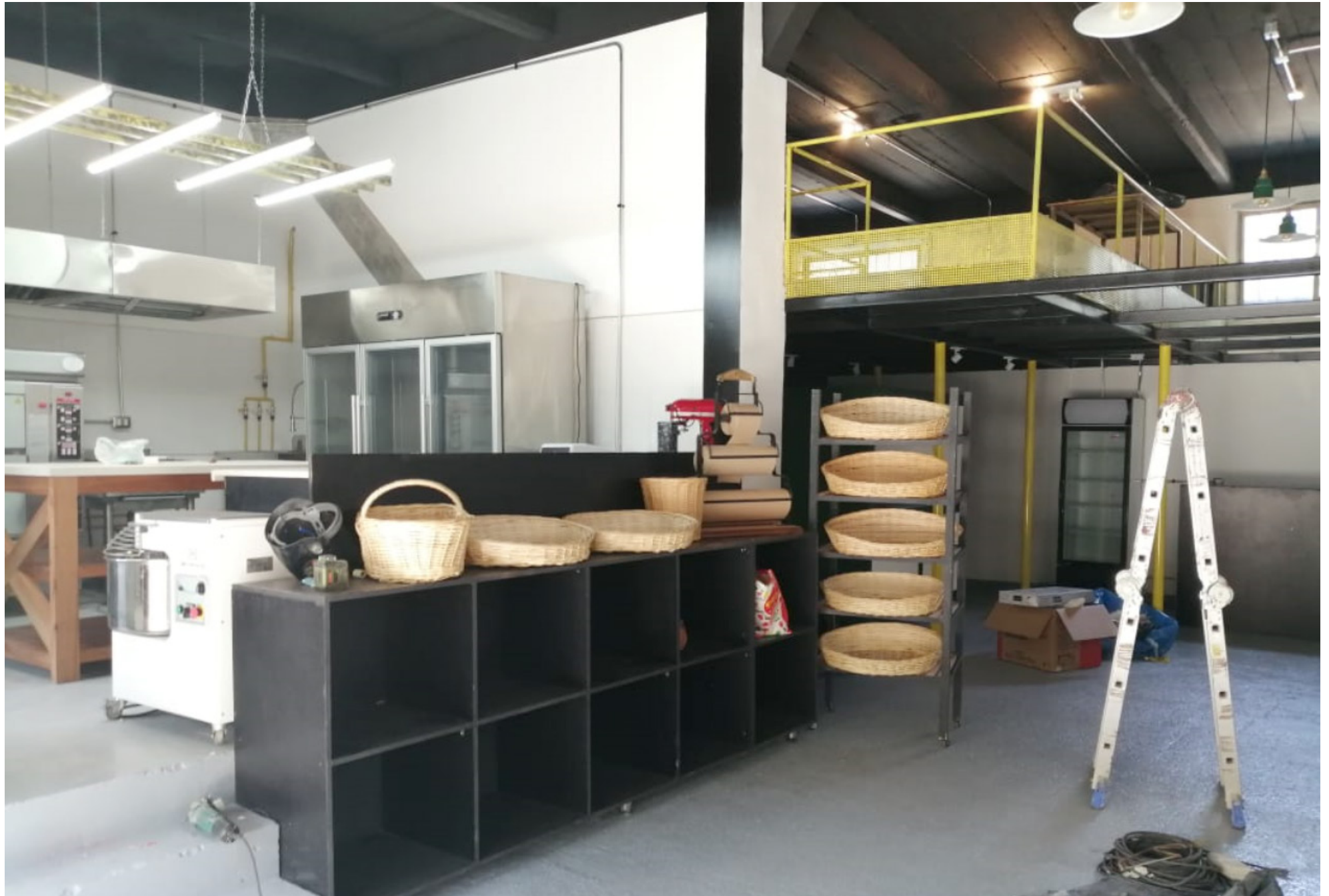
Fotografía de avance constructivo de Panadería en Persa Víctor Manuel Fuente: Elaboración propia
