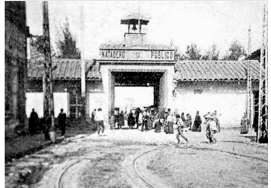
Frontis Matadero Público antes de su remodelación.
