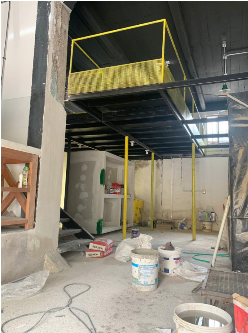
Visita a terreno para correcciones en la obra (el altillo se rehizo por 2da vez, debido a mala ejecución de constructores, no poseía la altura mínima habitable)
