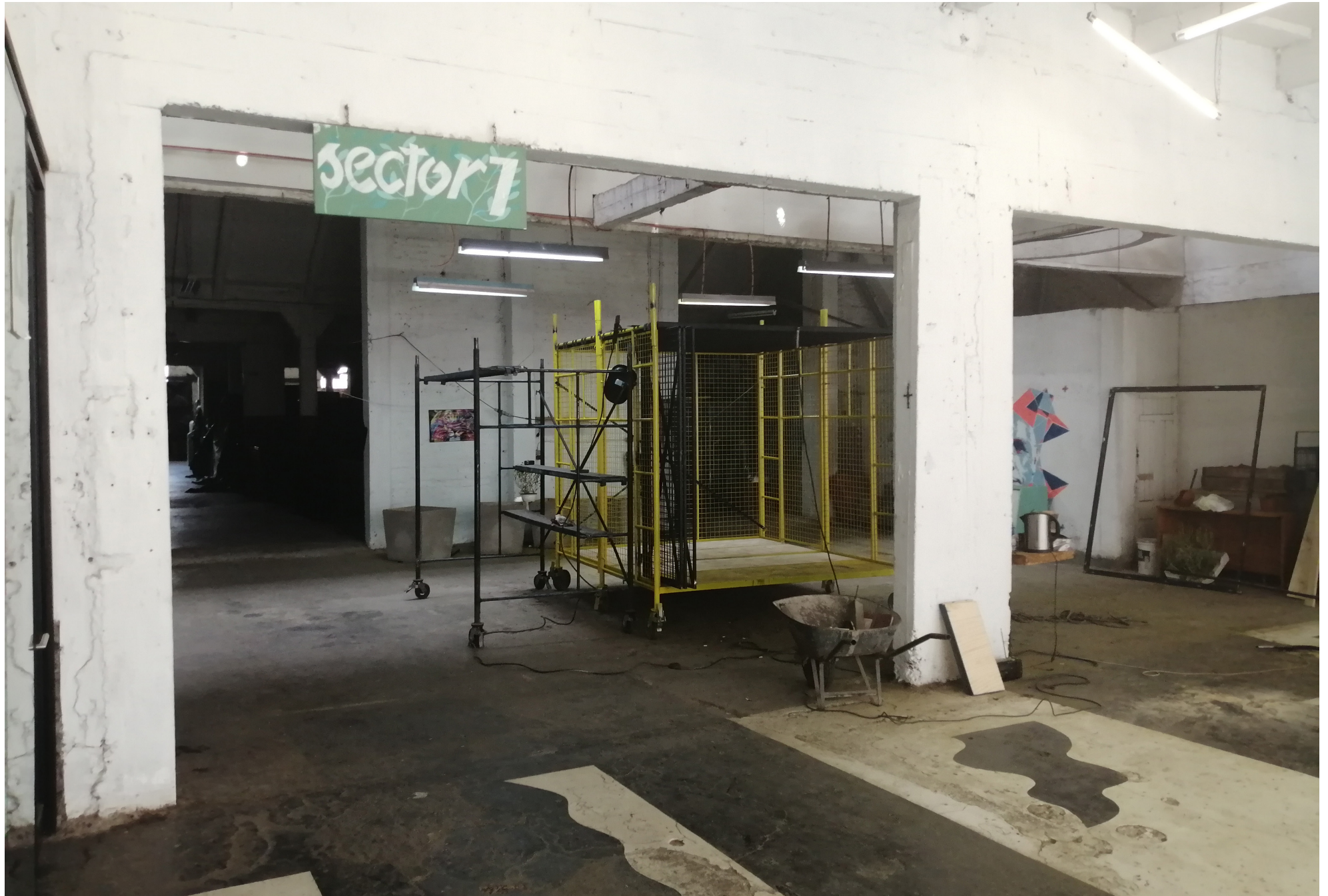
Fotografía en la Galería la Curtiembre, construyendo local comercial de prueba Fuente: Elaboración propia 2020
