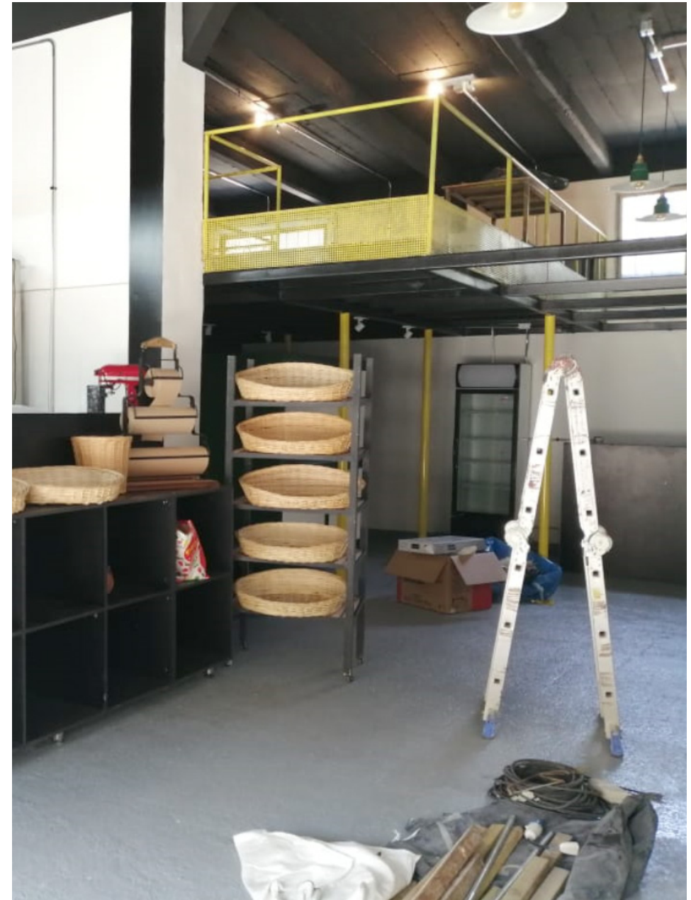
Proceso final en la construcción de la Panadería Levantamiento fotográfico de proceso constructivo, Panadería Fuente: Elaboración propia
