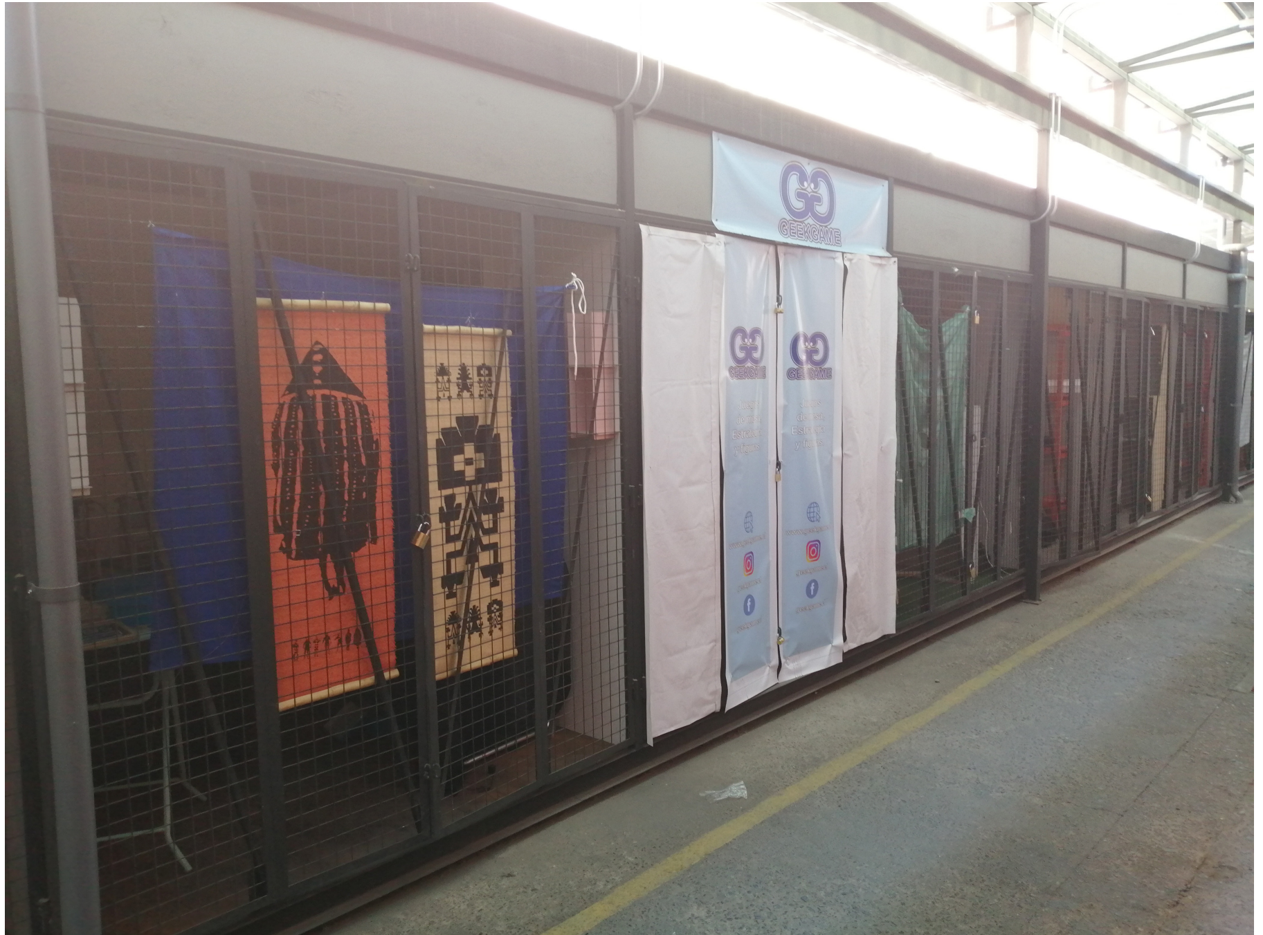
Fotografía locales construidos luego del incendio Fuente: Elaboración propia
