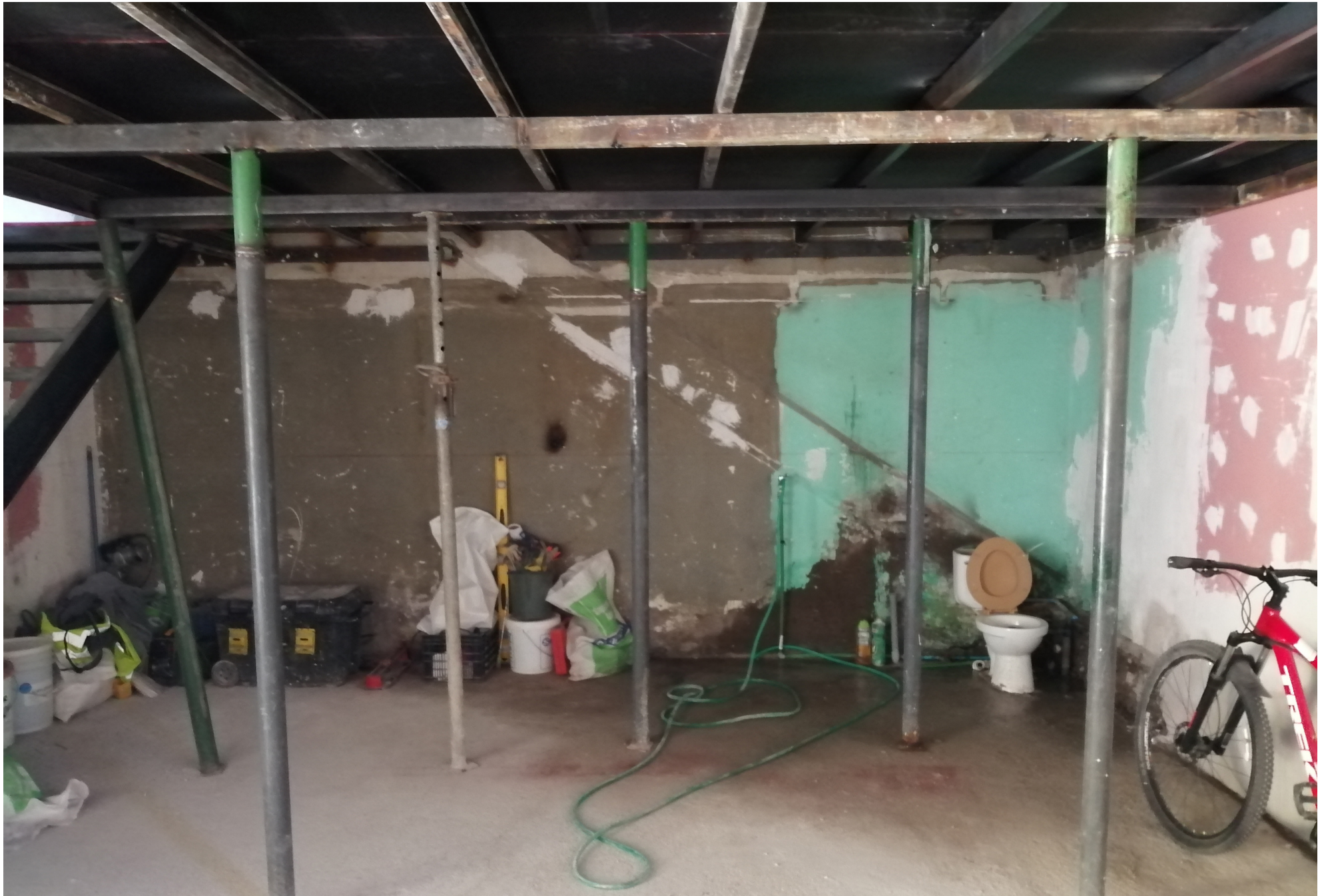
Registro fotográfico de proceso constructivo de pilares haciendo uso de fierros pre-existentes, en panadería en Persa Víctor Manuel Fuente: Elaboración propia
