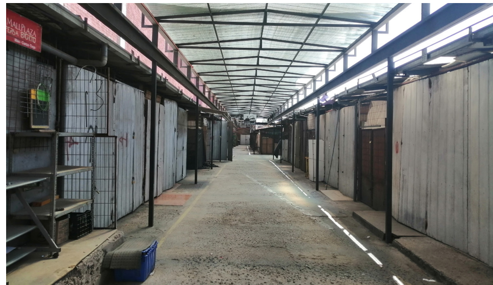
Pasillo del Sector 05, donde se muestra el trabajo de la techumbre. Fuente: Foto Propia
