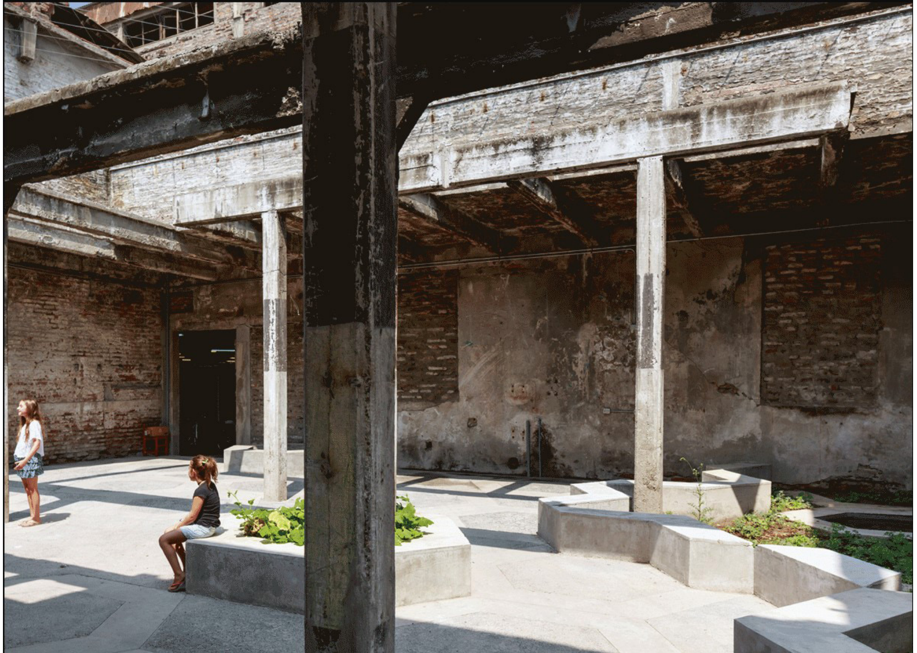
Foto de la Plaza Central, persa Victor Manuel 2016, fin de la obra Fuente: Plataforma Arquitectura
