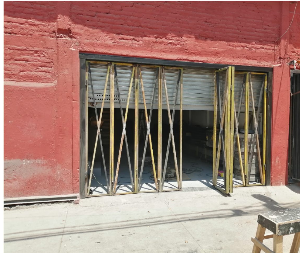
Registro fotográfico, resultado tras 2do proceso constructivo de reja en panadería en Persa Víctor Manuel Fuente: Elaboración propia
