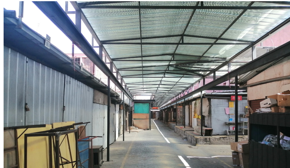
Pasillo del Sector 02, donde se muestra el trabajo de la techumbre. Fuente: Foto Propia
