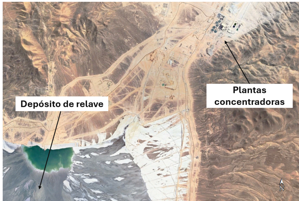
Figura 1.3: Vista en planta depósito de relaves estudiado. (Stantec, 2022).
