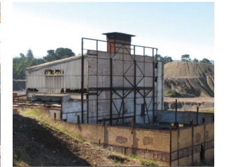
Planta de Fuerza, Sector Termoeléctrica. Fuente: Unidad de Patrimonio de Lota
