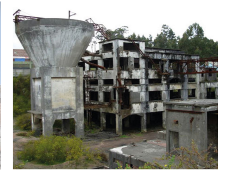
Planta de Lavados y su silo. Fuente: Unidad de Patrimonio de Lota
