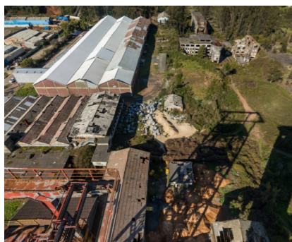
Vista aérea desde Piques hacia Sector Industrial y Planta de Lavado. Fuente: AéreoLota
