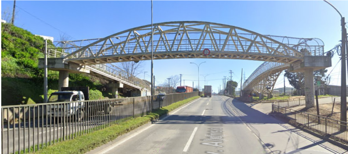
Figura 4.9: Pasarela peatonal materializada en hormigón y acero. (Fuente: Google Maps)
