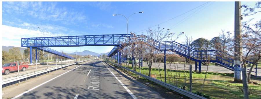
Figura 2.19: Pasarela Peatonal Curacaví; materializada en acero estructural. (Fuente: Google Maps)
