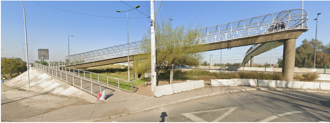
(a) Tramo 1 de pasarela
