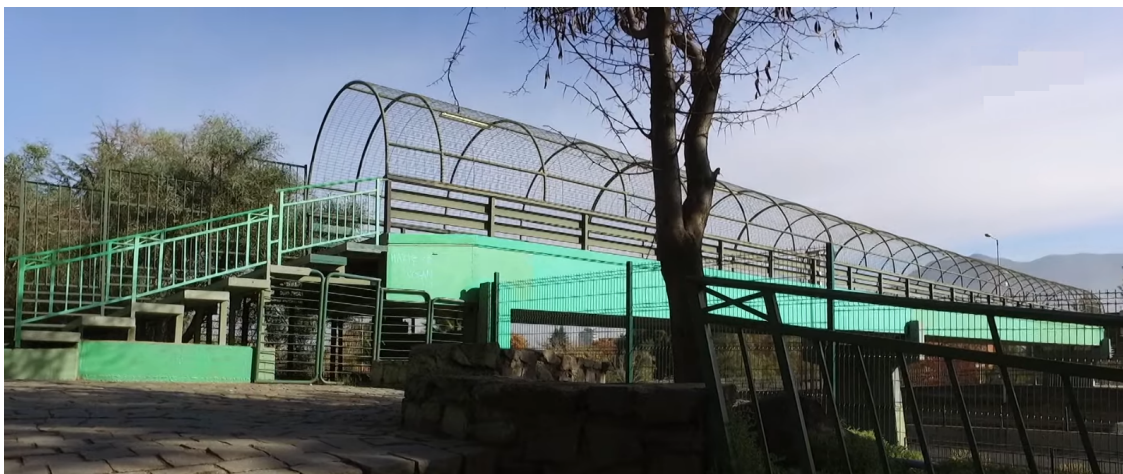
Figura 2.17: Rampa de la Pasarela Peatonal Parque Cuauhtémoc, Acceso plaza Brasilia. (Fuente: Ciudad Accesible)
