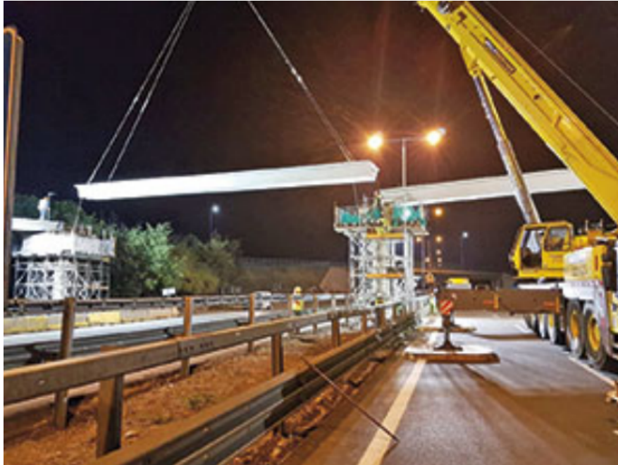
Figura 4.11: Vigas de pasarela siendo montadas, caso 1.
