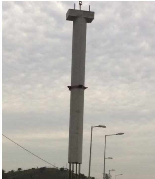
Figura 4.10: Pilar prefabricado de pasarela.
