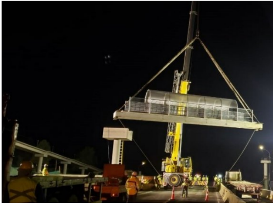
Figura 4.12: Vigas de pasarela siendo montadas, caso 2.
