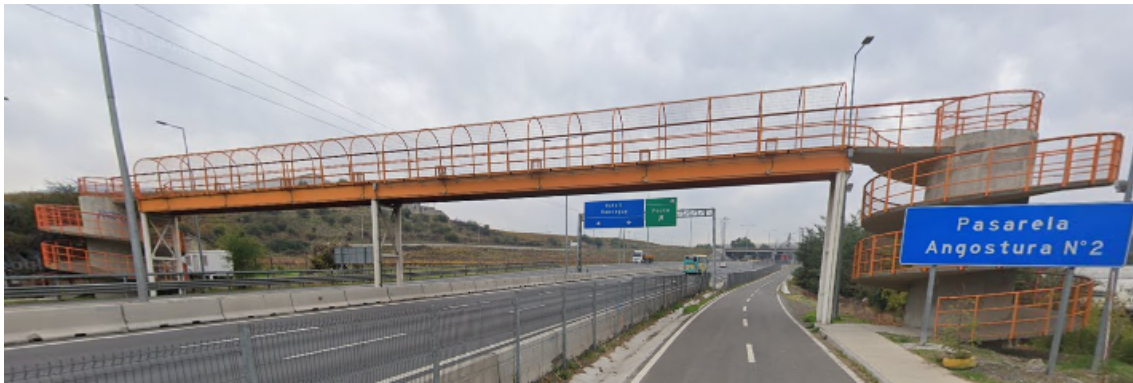
Figura 2.24: Pasarela Peatonal Angostura N°2, San Francisco de Mostazal. (Fuente: Google Maps)
