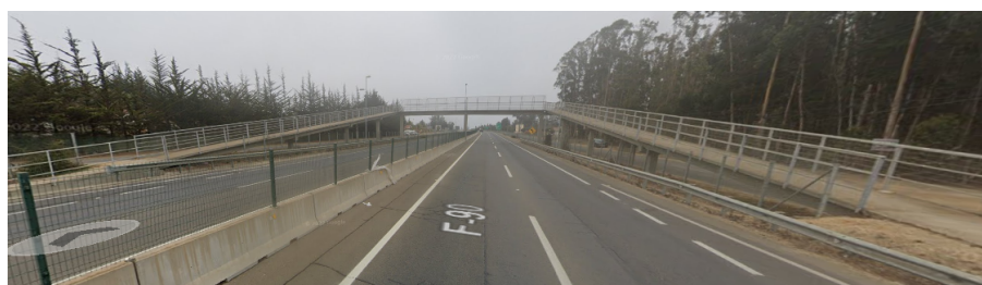
Figura 2.20: Pasarela Peatonal Chamorro, Algarrobo; materializada en hormigón prefabricado.
