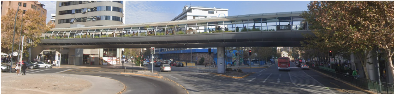
Figura 2.11: Pasarela Peatonal Costanera Center, Vista en elevación. (Fuente: Google Maps)
