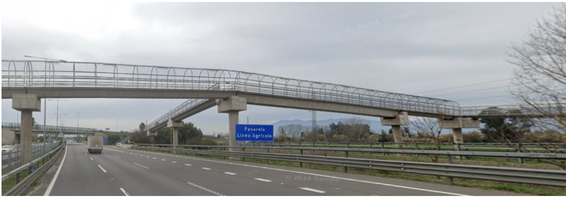
(b) Vista 2 de pasarela
