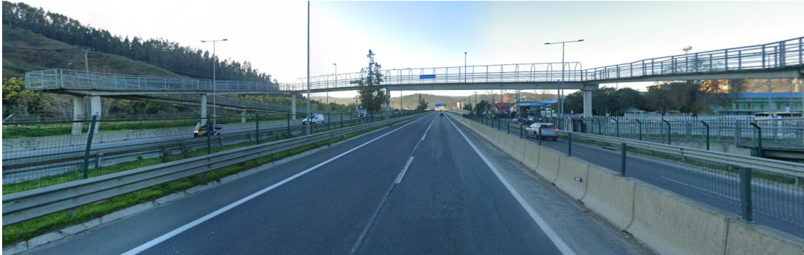
Figura 4.7: Pasarela peatonal materializada en hormigón prefabricado. (Fuente: Google Maps)
