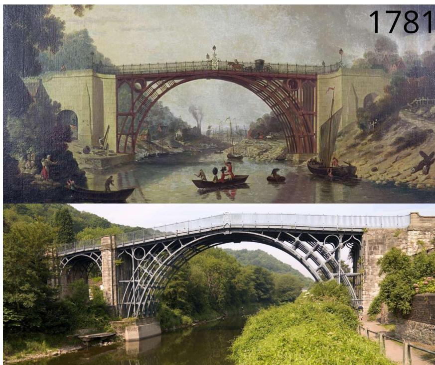
Figura 2.6: Comparación Iron Bridge, pintura versus realidad actual. (Fuente: Reddit)
