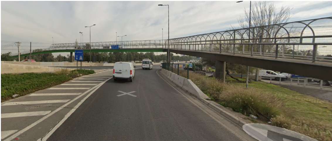
(b) Tramo 2 de pasarela
