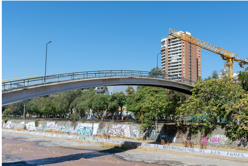
Figura 2.8: Puente Peatonal Condell. (Fuente: Wikipedia)
