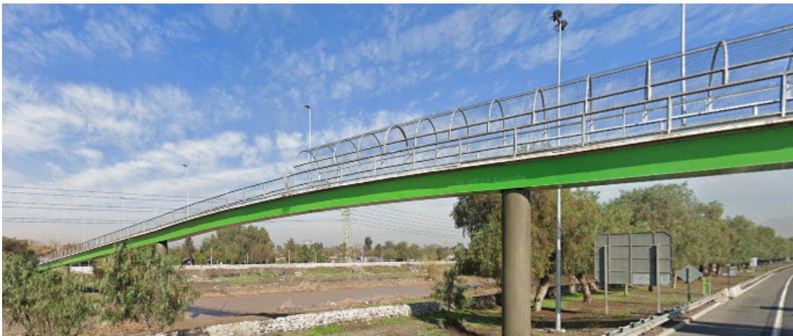
(c) Tramo 3 de pasarela
