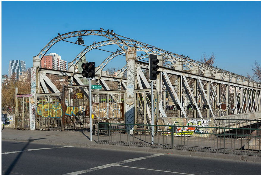
Figura 2.7: Puente Peatonal Los Carros. (Fuente: Wikipedia)
