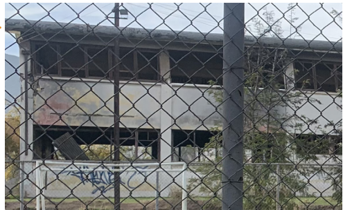
Acercamiento a pilares inclinados. Fuente: Fuentes (2022).
