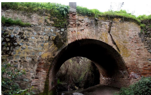
Estado actual del Puente Colonial San Carlos. Fuente: Consejo de Monumentos Nacionales (2014).
