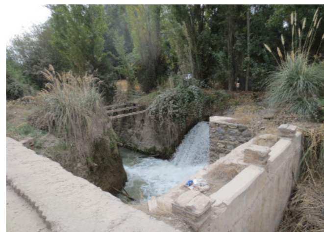
Compuertas de albañilería
