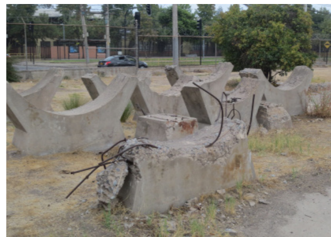
Soportes de hormigón
