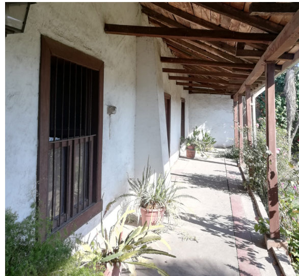
Figura 28: Vista hacia el lado derecho del corredor. Fuente: Colección de la autora (2023).
