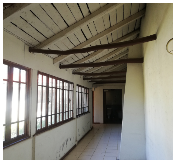
Figura 30: Pasillo interior central. Fuente: Colección de la autora (2023).
