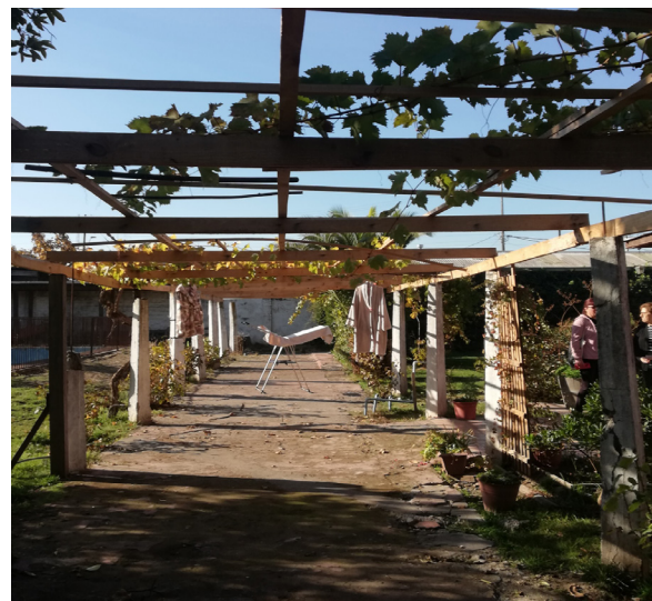
Figura 45: Vista de la pérgola. Fuente: Colección de la autora (2023).
