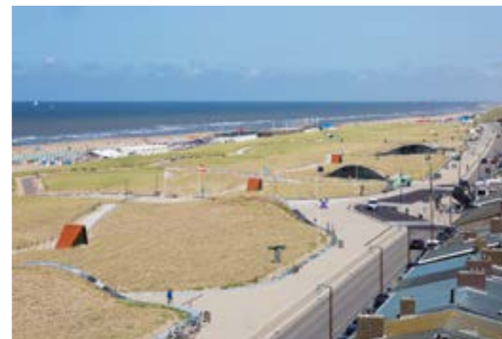
Figura 13. Estacionamiento subterráneo bajo parque dunar Katwijk aan Zee.
