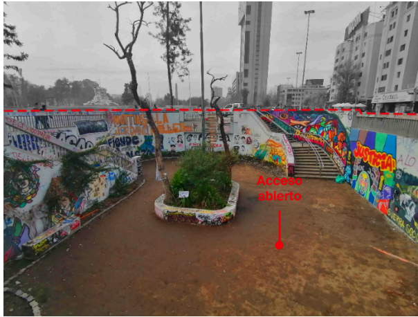
Acceso cerrado estación Baquedano
