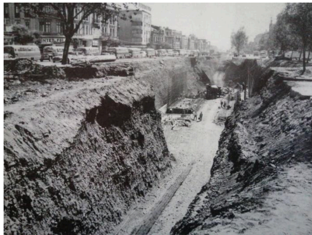
Ilustración 1 Sistema constructivo a cielo abierto Fuente: En la Ruta de Juan Parrochia Beguín
