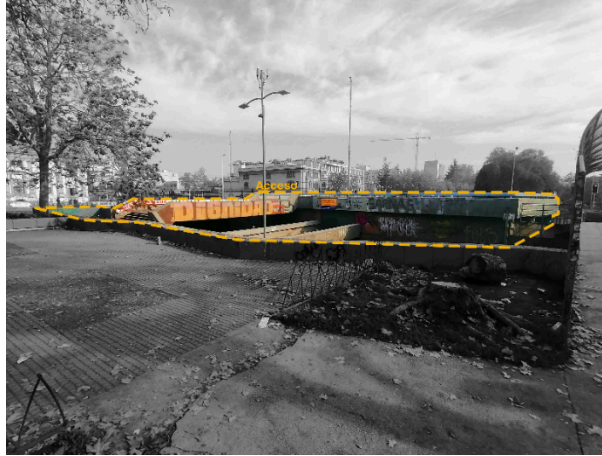
Acceso estación Los Héroes línea 2
