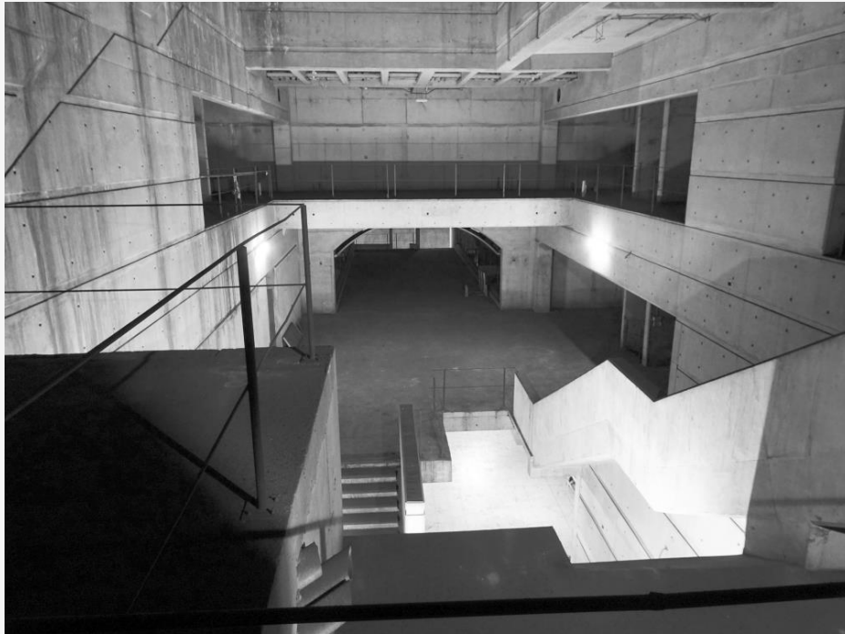
Imagen 2. Estado de Construcción de la Estación Libertad. Fuente:(Saavedra Araya, 2020)
