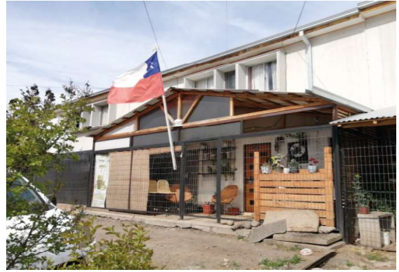
Figura 85 Fachada vivienda Mimbres Muñoz Fuente: Archivo personal
