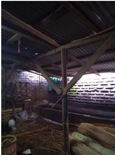
Figura 47 Estructura Taller. Fuente: Archivo personal
