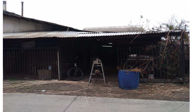
Figura 45 Fachada Vivienda. Fuente: Elaboración propia
