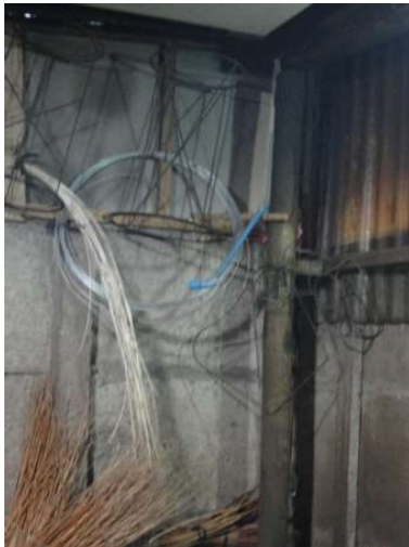
Figura 39 Estructura Taller Fuente: Archivo Personal
