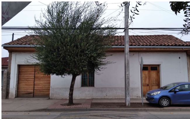
Figura 74 Vista Fachada vivienda. Fuente: Archivo personal
