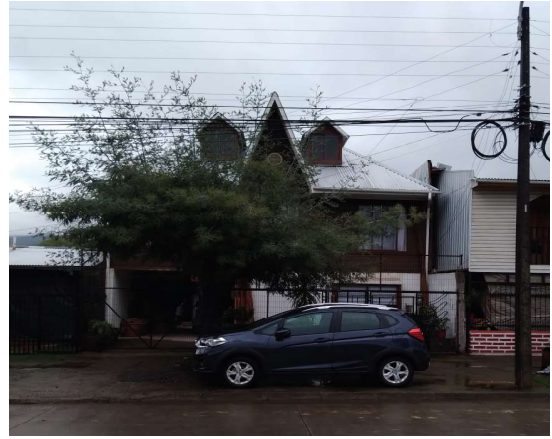
Figura 37 Fachada Vivienda. Fuente: Archivo personal.
