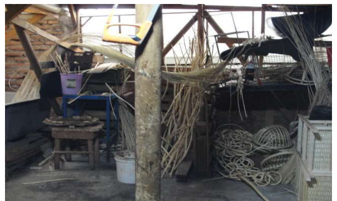
Figura 57 Estructura taller. Fuente: Archivo personal
