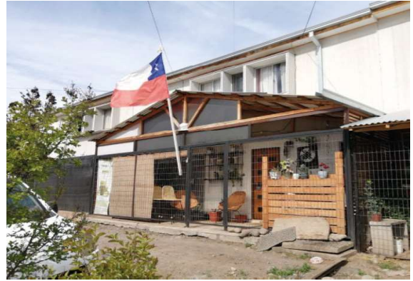
Figura 85 Fachada vivienda Mimbres Muñoz Fuente: Archivo personal
