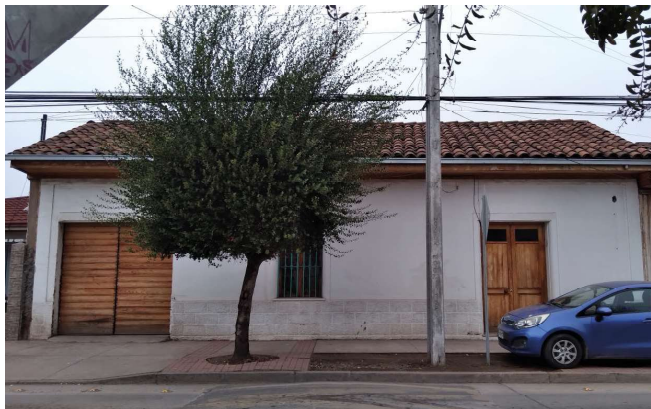
Figura 74 Vista Fachada vivienda. Fuente: Archivo personal
