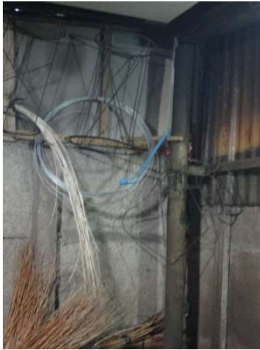
Figura 39 Estructura Taller Fuente: Archivo Personal
