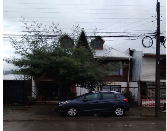
Figura 37 Fachada Vivienda. Fuente: Archivo personal.
