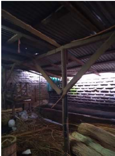
Figura 47 Estructura Taller. Fuente: Archivo personal
