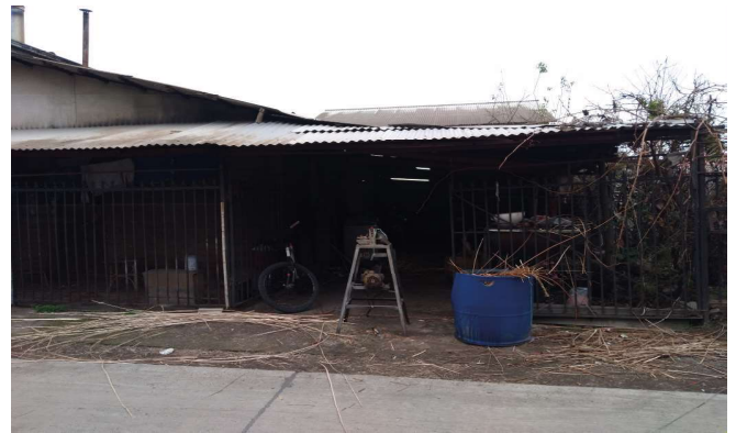
Figura 45 Fachada Vivienda. Fuente: Elaboración propia
