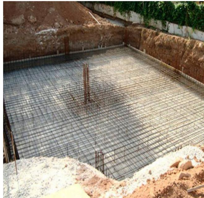
Figura 8: Losas Flotantes aplicadas a proyecto. siingeniería. s.f.
