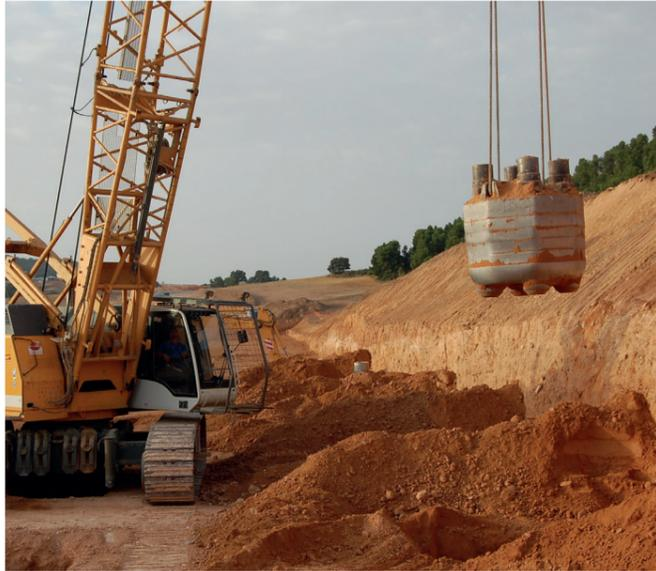
Figura 3.6: Compactación Dinámica aplicada en terreno, s.f. Menard. s.f.
