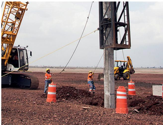
Figura 3.8: Aplicación de Pilotes Hincados en terreno s.f. Cimesa. s.f.
