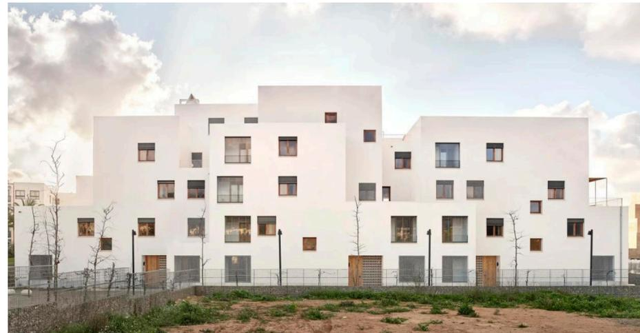
Conjunto de 43 viviendas sociales desarrolladas por Peris + Toral Arquitectes, con un sistema de muros de carga ensamblados con bloques de tierra comprimida de 20 centímetros de grosor. Los bloques son fabricados por GLS Prefabricados utilizando una mezcla de tierra, áridos arcillosos no expansivos y cal, y comercializados por FET DE TERRA. Permitieron versatilidad al proyecto, disminución del costo y una baja huella de carbono.
