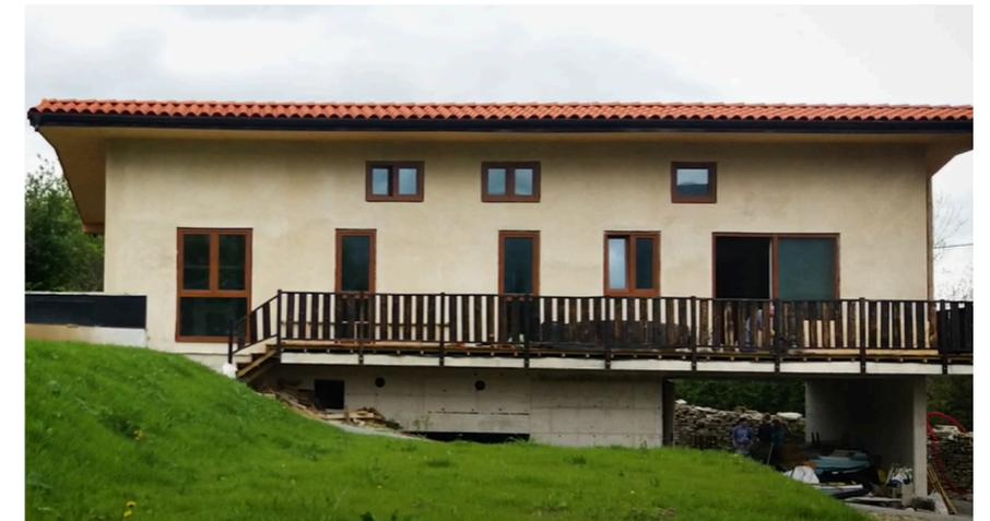
Diseñada por la firma Meta Arquitectos, es una vivienda de 113 m<sup>2</sup> construida con módulos prefabricados de madera y paja, en un montaje de 10 días. Tiene un gran aislamiento térmico en toda la envolvente siendo catalogada como Passive House, consumiendo solo 18 kw/m<sup>2</sup> de energía en un año. Los paneles utilizan materiales locales, son sumideros de carbono (paja y madera), y están catalogados con F-150 y U:0,144 W/m<sup>2</sup>k. de transmitancia térmica.
