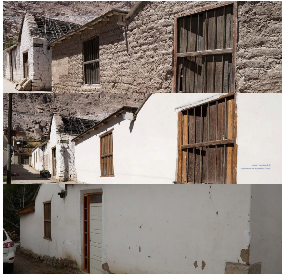
Fig. 52 Antes y después de la intervención de fachada de vivienda realizada en ayuda de la Fundación Altiplano. Fuente: Extraído de Pueblos Andinos, Arica y Parinacota, 2018.
