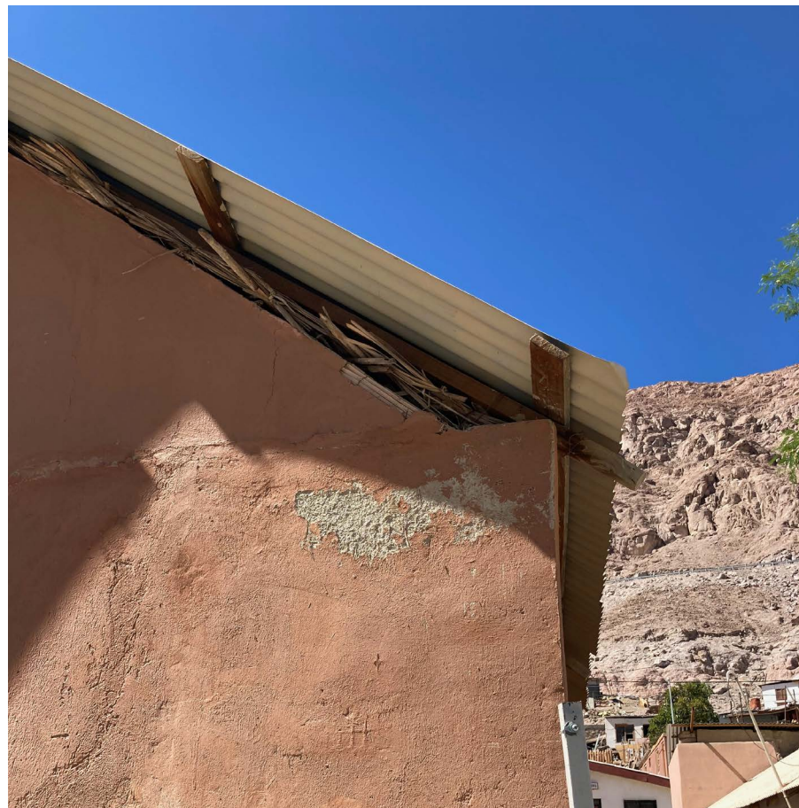
Fig. 42 Reemplazo de la techumbre tradicional por planchas de zinc acanaladas. Fuente: Elaboración propia , 2022.
