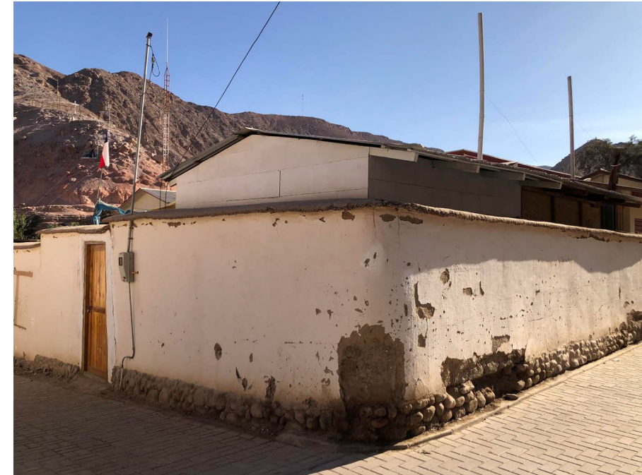
Fig. 81 Caso N°19 Vivienda de madera con Cerco Perimetral de muros de adobe. Fuente: Elaboración propia,
