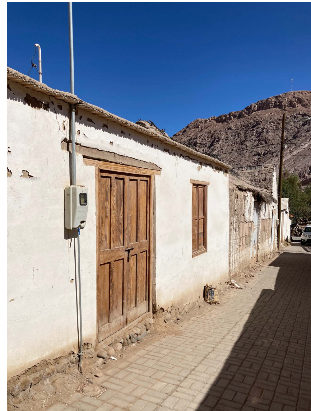
Fig. 33 Fachada de vivienda restaurada en el año 2015 por la Fundación Altiplano. Fuente: Elaboración propia, 2021.
