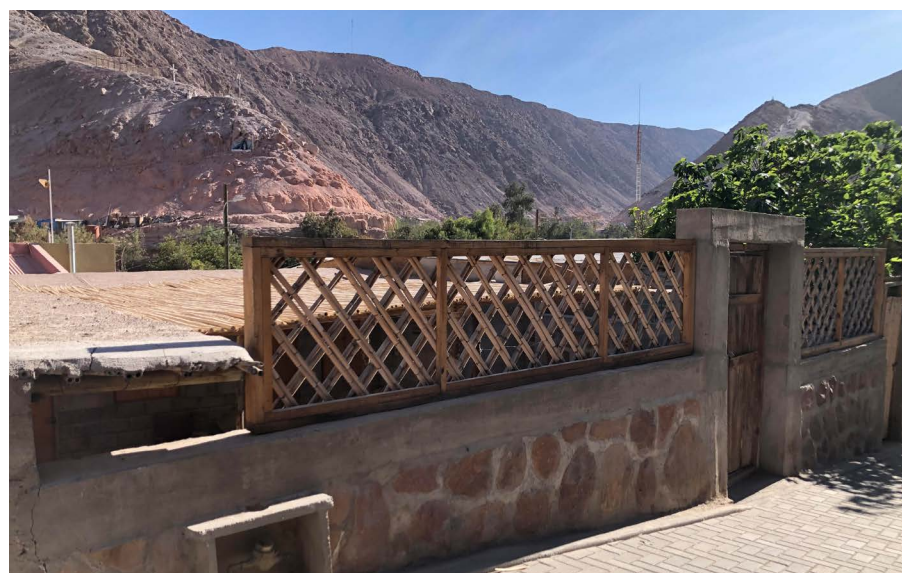
Fig. 84 Caso N° 34 Vivienda nueva de muros de albañilería de blo- ques de cemento que incorpo- ra la techumbre tradicional. Fuente: Elaboración propia, 2022.
