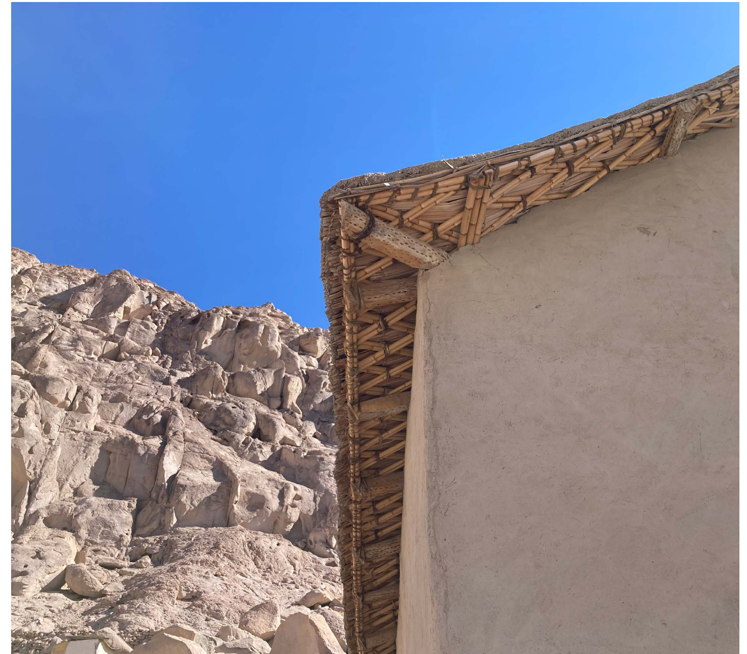
Fig. 32 Bodega "El Tapial" restaurada el año 2014 por la Fundación Altiplano, conserva el uso del cactus candelabro ( Browningia candelaris ) como soporte de la techumbre, recurso constructivo tradicional que hoy se encuentra en estado de conservación vulnerable. Fuente: Elaboración propia, 2021.
