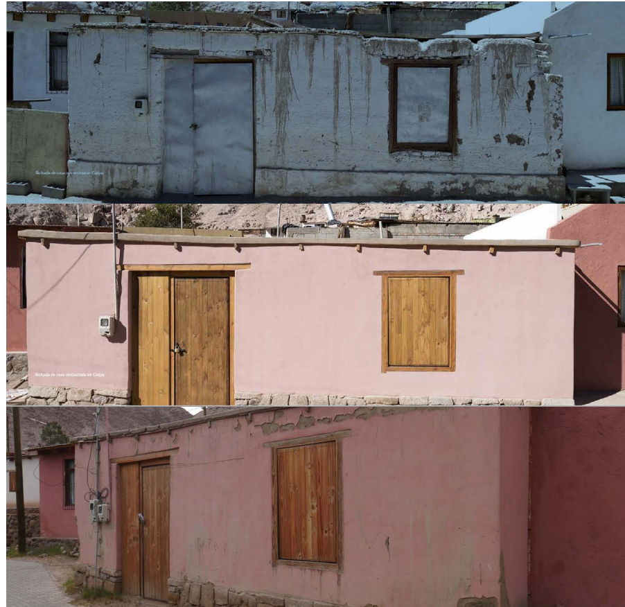
Fig. 50 Antes y después de la intervención de fachada de vivienda realizada en ayuda de la Fundación Altiplano. Fuente: Extraído de Pueblos Andinos, Arica y Parinacota, 2018.
