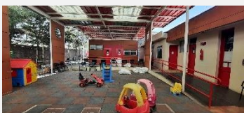
1.PATIO PISO SEGURO: Vista hacia los boxes de educación donde a parte de la puerta se distingue un solo vano por sala. Fuente: Elaboración propia
