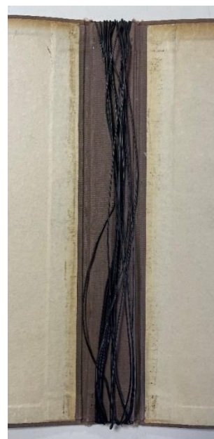
Figura 50. Alambres de sistema de sujeción.
