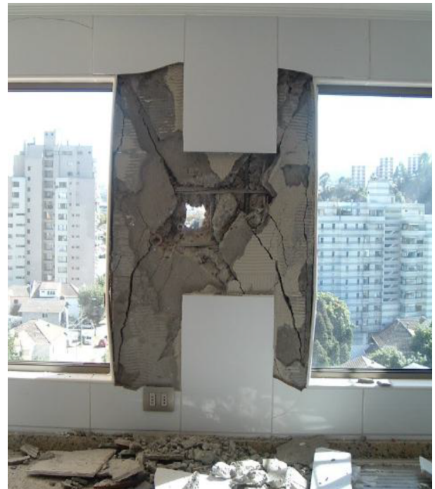
(b) Detalle de falla por corte en machón.
