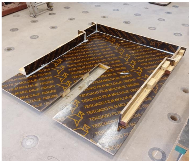
Figura 9. Moldaje de losas de acople.
