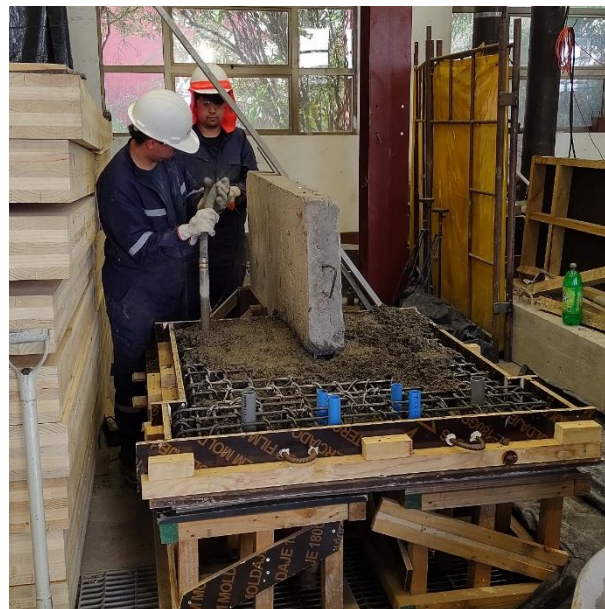
Figura 11. Compactación del hormigón.
