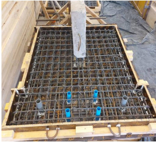
a) Armadura de probeta BC.
