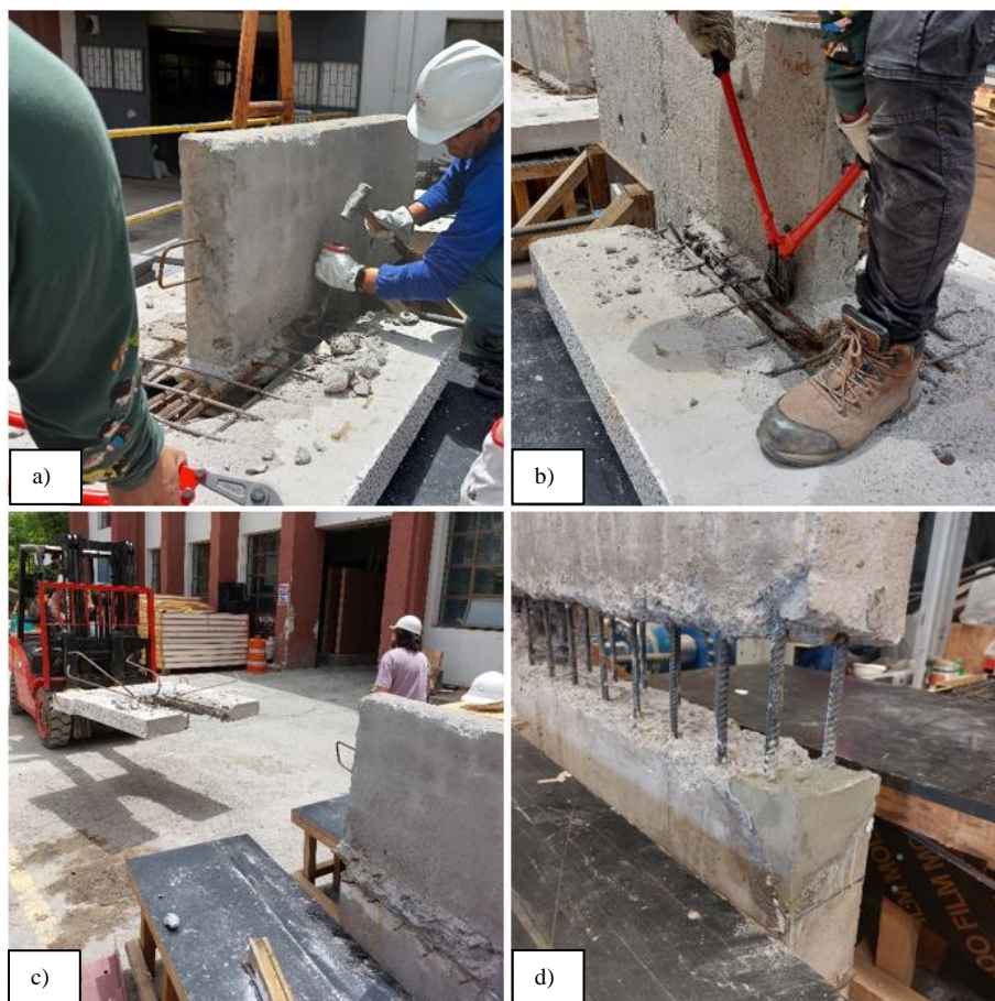
a) Picado del hormigón en la zona de falla por punzonamiento. b) Corte de las armaduras transversales y longitudinales. c) Desacople de la losa. d) Picado del hormigón en la zona de interfaz muro-losa.
