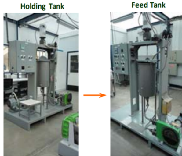
Figura 5.5: Estanques de almacenamiento y alimentación a CFM.
