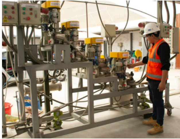
Figura 5.3: Celdas de flotación ubicadas en desnivel.
