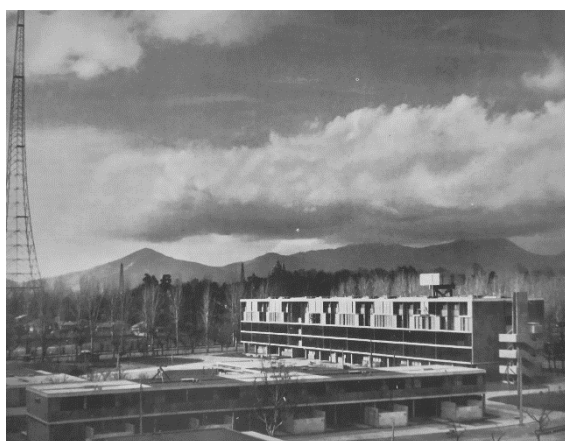
Fig. 2, Vista parcial de la Unidad Vecinal Portales
