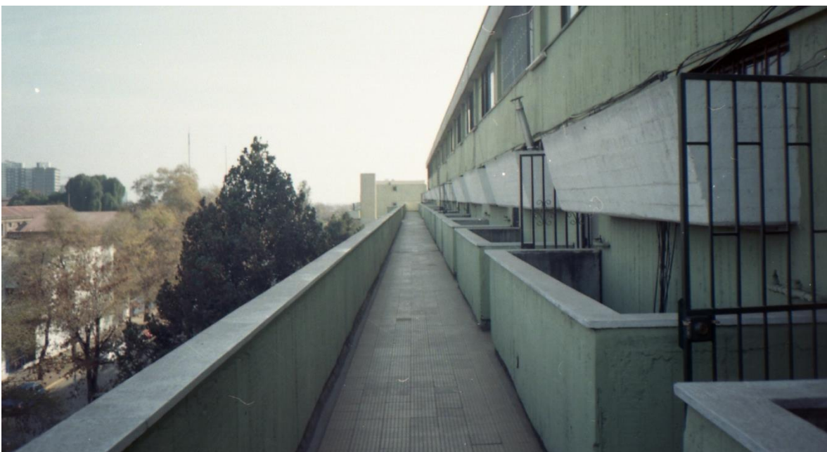
Fig. 16, Vista del pasillo exterior del block 19
