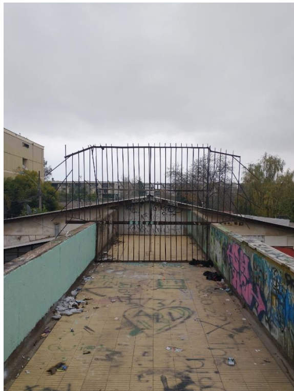
Fig. 17, Cierre de las pasarelas por sobre las casas hacia el block 8
