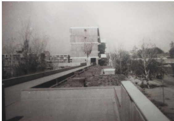
Fig. 7. Vista hacia el block 3 desde la pasarela
