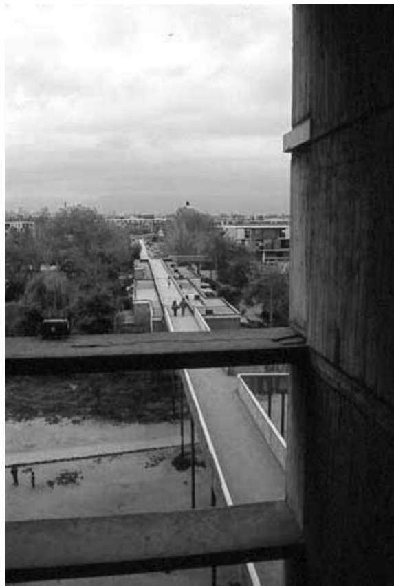
Fig. 6, Pasarelas elevadas entre los bloques 1 y 2
