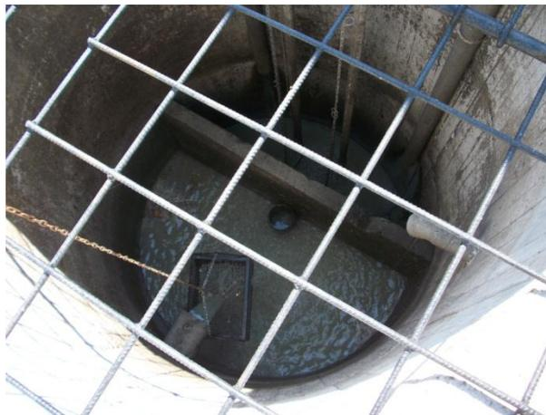
**Figura C.12:** Sistema de rejas planta de tratamiento Patagua Cerro
