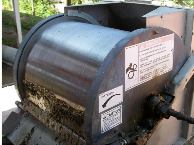
**Figura C.8:** Sistema de rejas rotatorio planta de tratamiento María Pinto
