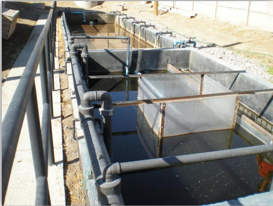
**Figura C.1:** Sedimentador Secundario Punta Azul
