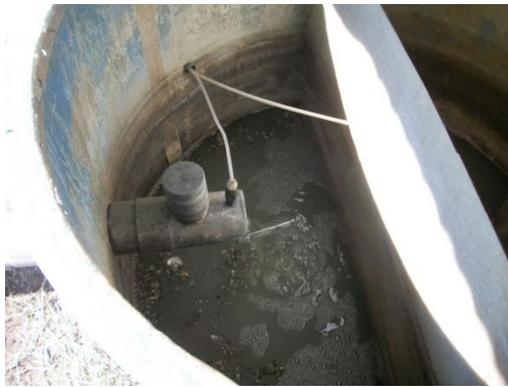
**Figura C.14:** Aplicación cloro planta de tratamiento Punta de Cortés
