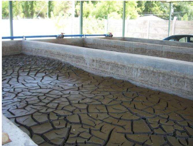
**Figura C.11:** Cancha de Secado planta de tratamiento Larmahue
