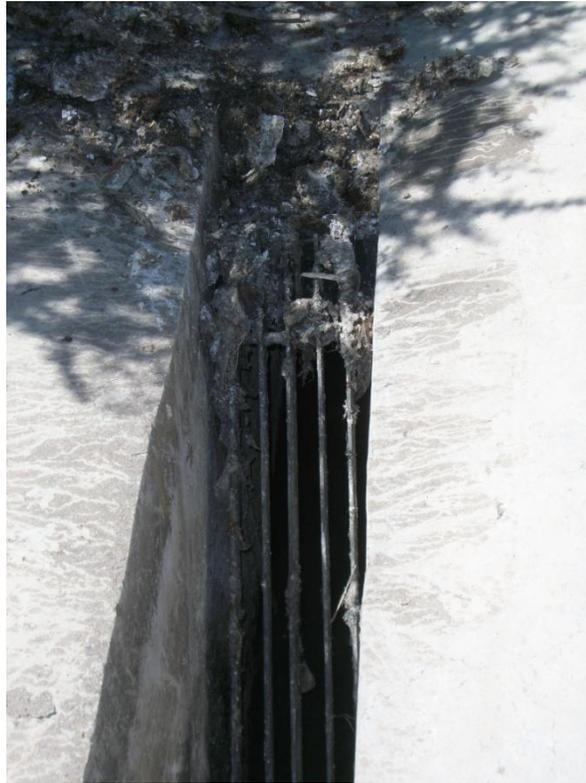
**Figura C.15:** Sistema de rejas planta de tratamiento La Estrella
