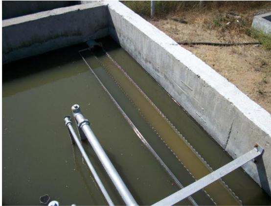
**Figura C.13:** Clarificador planta de tratamiento Patagua Cerro
