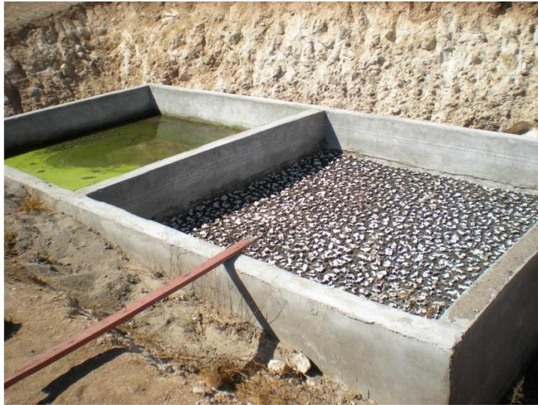
**Figura: C.4:** Cancha de secado planta de tratamiento Gualliguaica
