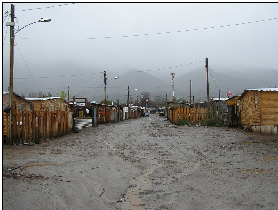
Fig. 28: Predio de la "Ex - toma de Peñalolén" una vez realizado el "Plan de Salida". Viviendas ocupadas por pobladores rezagados en la solución habitacional.
