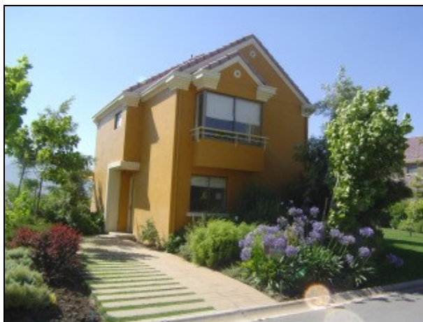
Foto 13: Vivienda en CDLV
