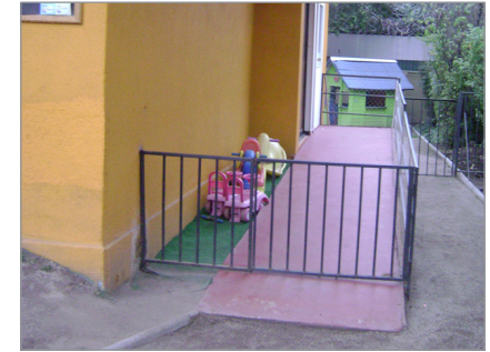
Acceso con rampa
