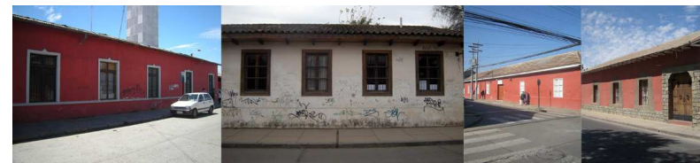
Regularidad y verticalidad en vanos
