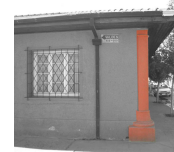
Pilar esquina incrustado en muro
